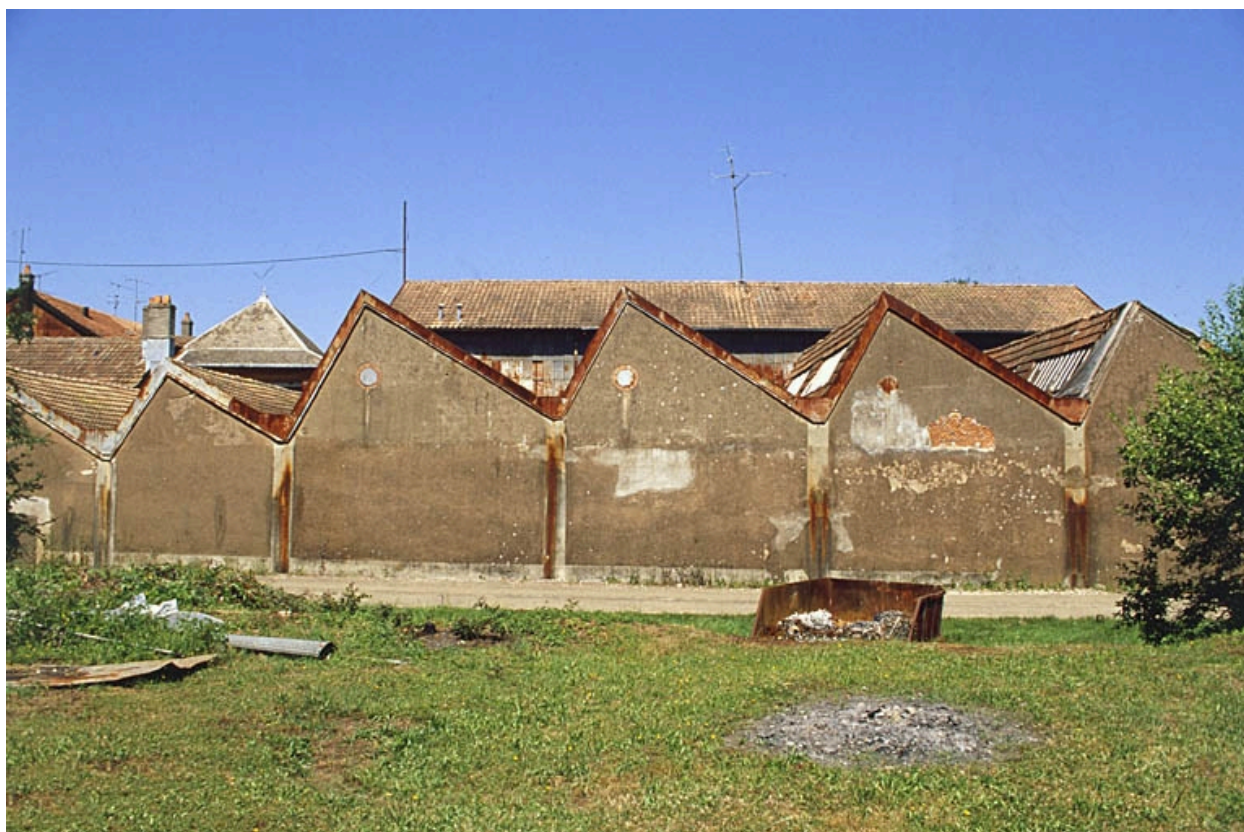
Pignons des sheds au sud.
