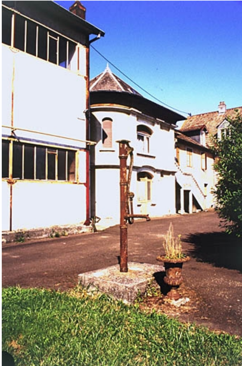
Atelier et logement depuis l'est.
