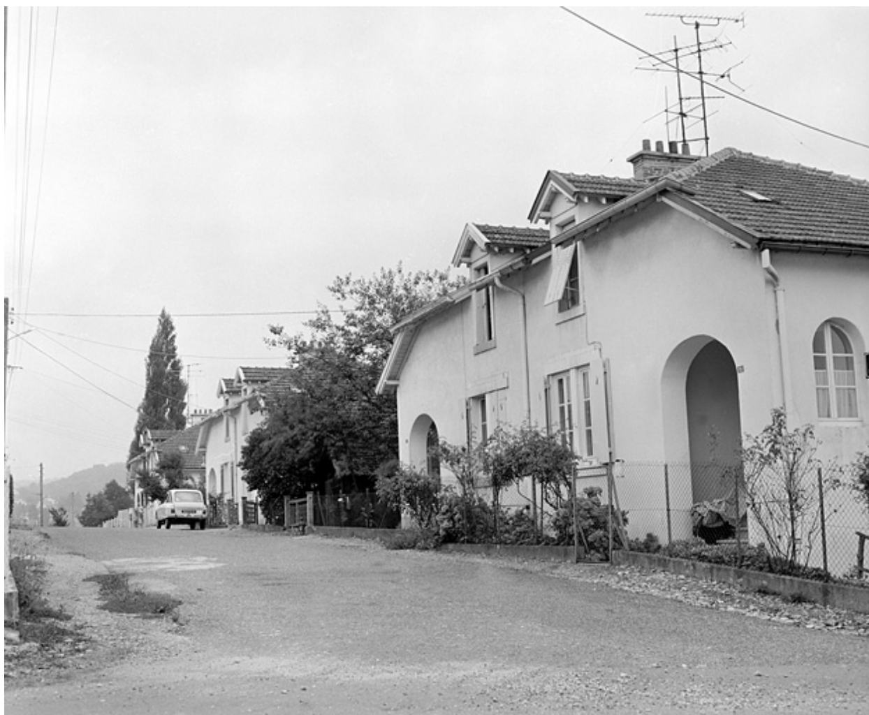
Vue de la rue des Fondeurs.SRI. Enquête régionale sur les bâtiments industriels (1979-1981).
