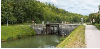
Vue d'ensemble, d'aval.
