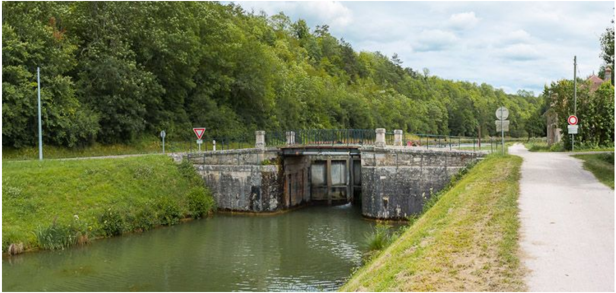
Vue d'ensemble, d'aval.
