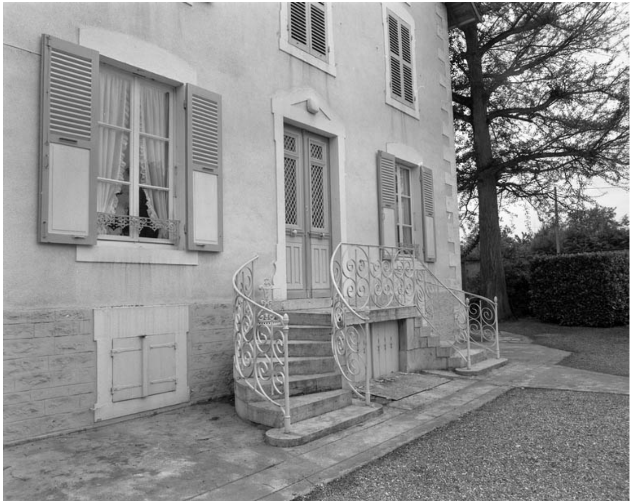
Détail du perron de l'habitation.
