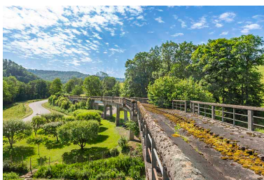
Viaduc du Martinet du Haut.
