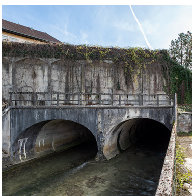
Couverture de la Furieuse (quartier de la gare terminus). Sortie aval.
