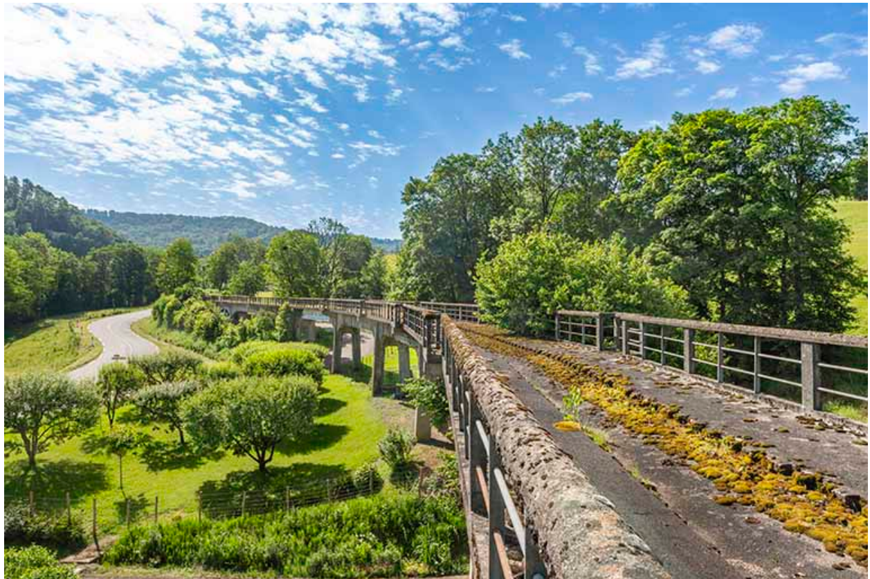
Viaduc du Martinet du Haut.
