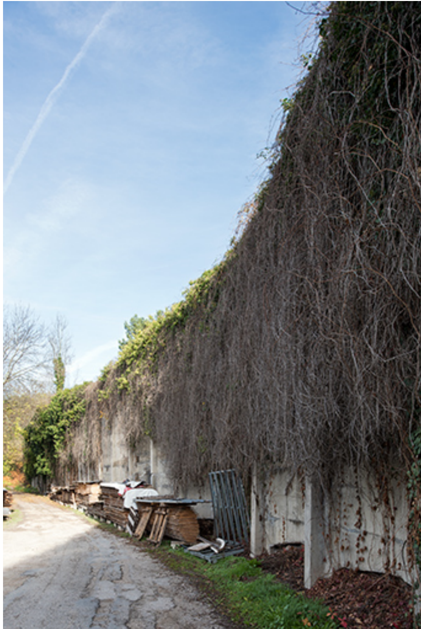
Mur de soutènement (quartier de la gare terminus).
