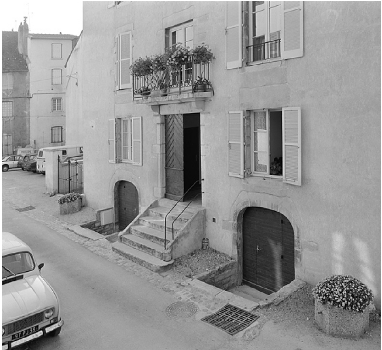
Façade antérieure, le rez-de-chaussée.
