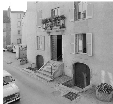
Façade antérieure, le rez-de-chaussée. Phot. Yves Sancey IVR43_19853900325X
