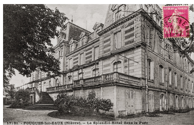
Façade ouest. Autr. auteur inconnu IVR26_20195800761NUC4A
