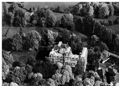
Vue aérienne de l'hôtel en 1958. Phot. Pierre-Marie Barbe-Richaud, Autr. Établissements Richard IVR26_20205800338NUC4A
