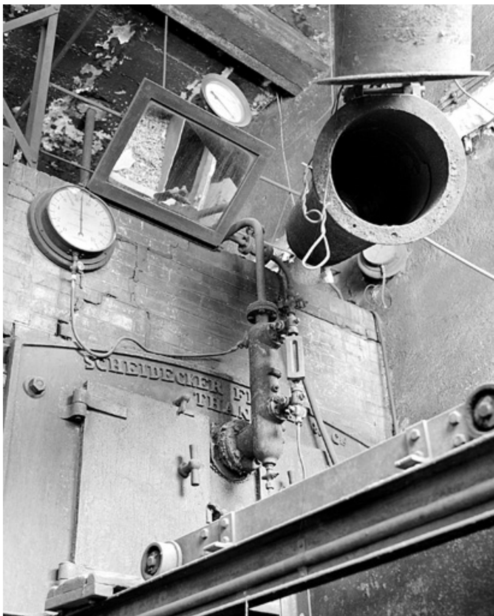
Détail de la partie haute de la chaudière de 1927 (cadrage vertical). Tuyau articulé de chargement de la trémie à droite ; rail et chariot de la trémie en bas.
