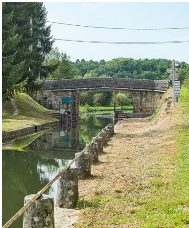
Vue du pont.
