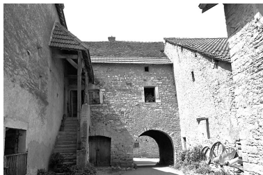
Façade sur cour. Phot. Dominique Humbert IVR43_19767000471X
