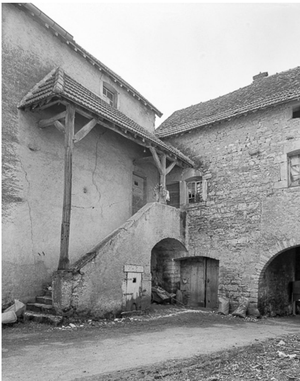
Vue de l'escalier extérieur.
