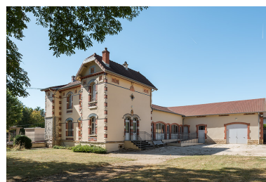
Bâtiment du forage (à gauche) avec hangar et usine d'embouteillage (à droite). Phot. Pierre-Marie Barbe-Richaud IVR26_20192100312NUC4A
