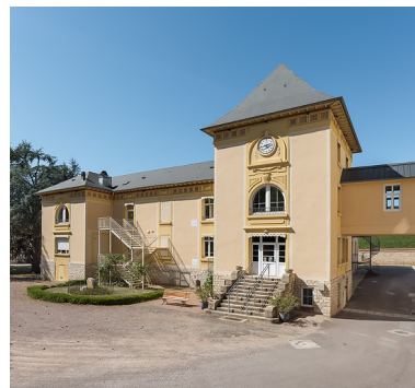
Bâtiment des bains, façade principale vue depuis le sud-est, et passerelle vers l'hôtel (à droite). Phot. Pierre-Marie Barbe-Richaud IVR26_20192100306NUC4AQ
