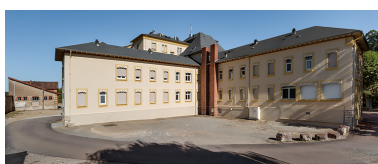
Bâtiment des bains, élévation postérieure, vue depuis l'ouest. Phot. Pierre-Marie Barbe-Richaud IVR26_20192100317NUC4AQ
