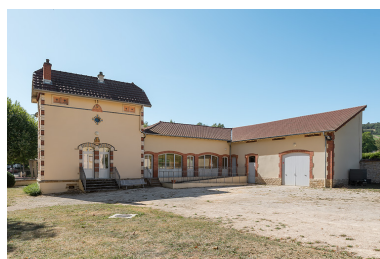
Bâtiment du forage (à gauche) avec hangar et usine d'embouteillage (à droite). Phot. Pierre-Marie Barbe-Richaud IVR26_20192100311NUC4A
