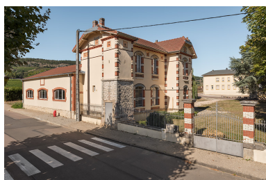
Bâtiment du forage et grille de clôture, vue depuis l'avenue des Sources, état actuel. Phot. Pierre-Marie Barbe-Richaud IVR26_20192100315NUC4A
