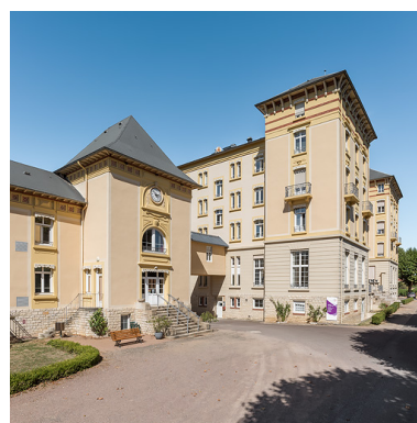
Situation du bâtiment des bains par rapport à l'hôtel, vue depuis le sud. Phot. Pierre-Marie Barbe-Richaud IVR26_20192100307NUC4AQ
