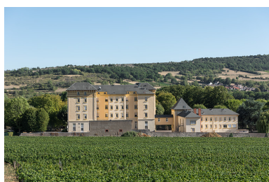
Situation du bâtiment des bains par rapport à l'hôtel, vue depuis le nord. Phot. Pierre-Marie Barbe-Richaud IVR26_20192100318NUC4A
