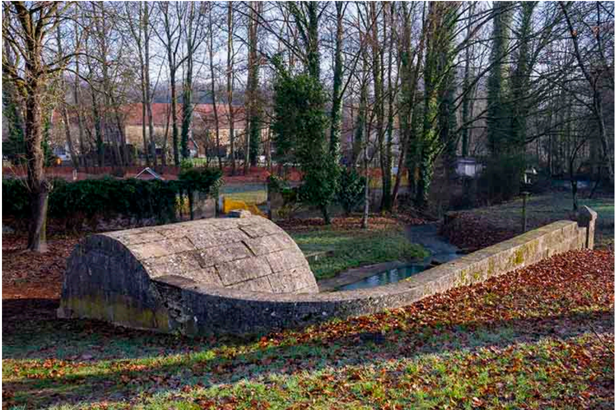
Mur de soutènement, vue depuis le nord.
