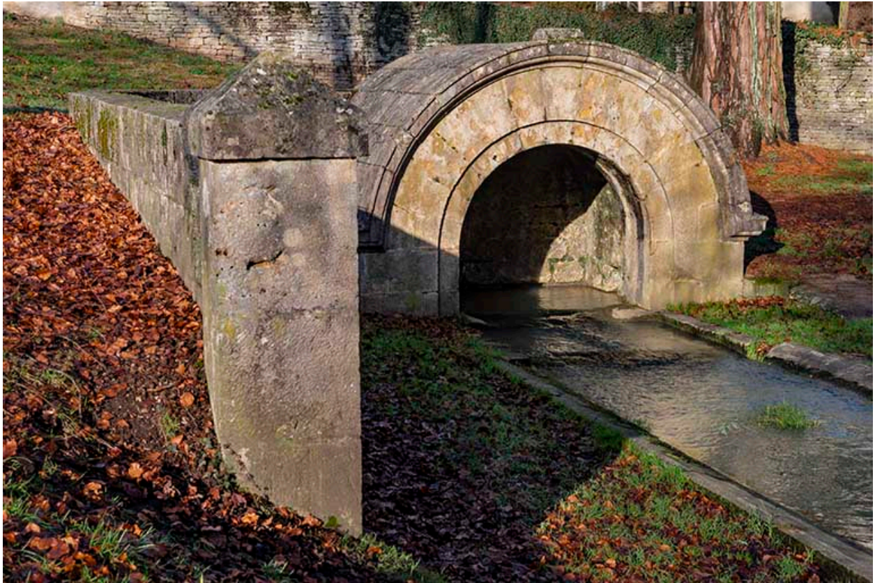
Mur de soutènement, vue depuis le sud.
