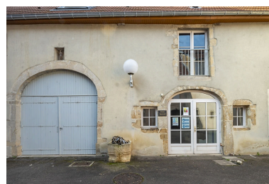
La façade du bâtiment situé au fond de la cour. Phot. Jérôme Mongreville IVR43_20227000007NUC4A
