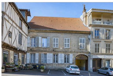
La façade de la maison. Phot. Jérôme Mongreville IVR43_20217000651NUC4A
