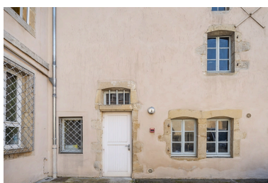
Détail de la façade gauche dans la cour. Phot. Jérôme Mongreville IVR43_20227000009NUC4A
