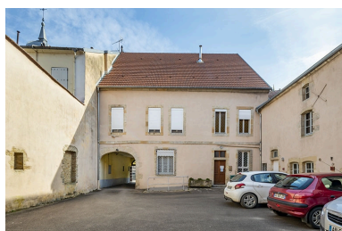
La façade postérieure, depuis la cour. Phot. Jérôme Mongreville IVR43_20227000006NUC4A
