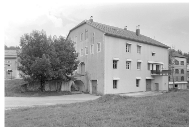
Façade postérieure et face nord-ouest. Phot. Jérôme Mongreville IVR43_19963901328X
