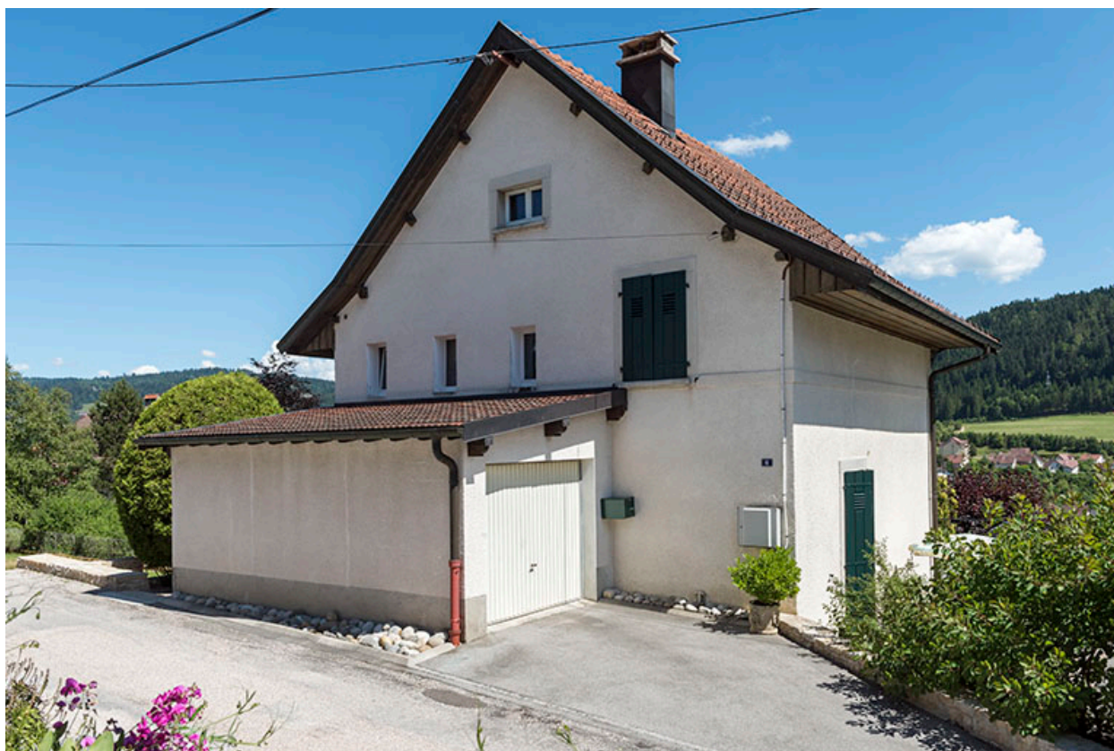
Façades antérieure et latérale droite.
