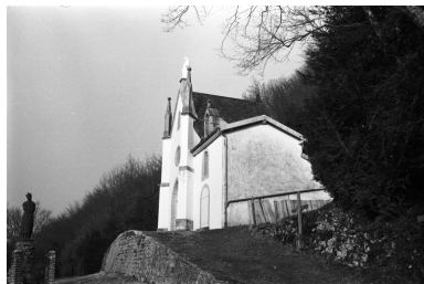
Vue générale. Phot. Guy Forestier IVR43_19743900540Z
