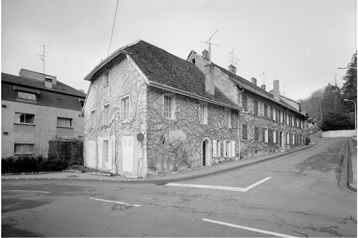
Vue d'ensemble des façades sud et est.
