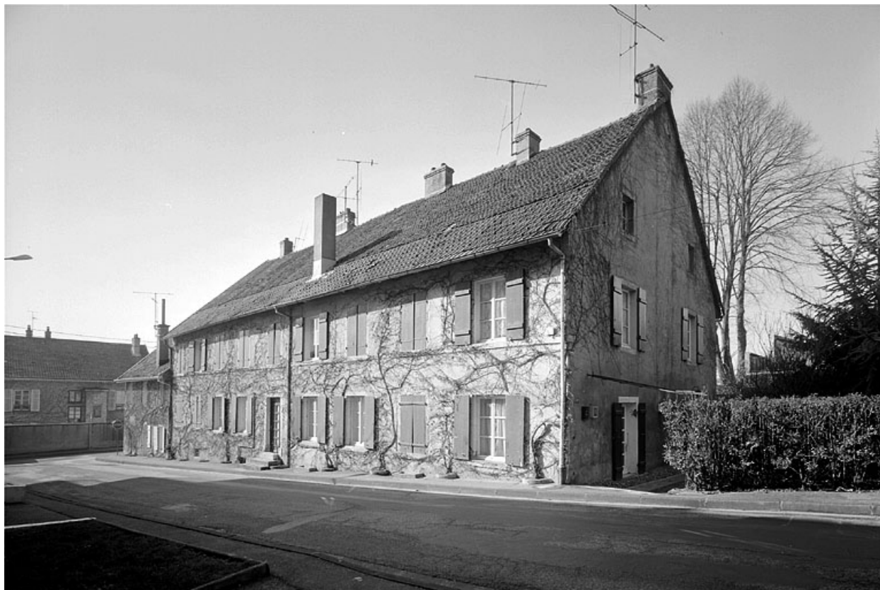
Vue d'ensemble de la façade est.
