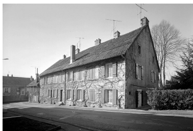
Vue d'ensemble de la façade est. Phot. Jérôme Mongreville IVR43_19882500027V
