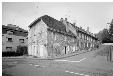
Vue d'ensemble des façades sud et est. Phot. Jérôme Mongreville IVR43_19882500021V
