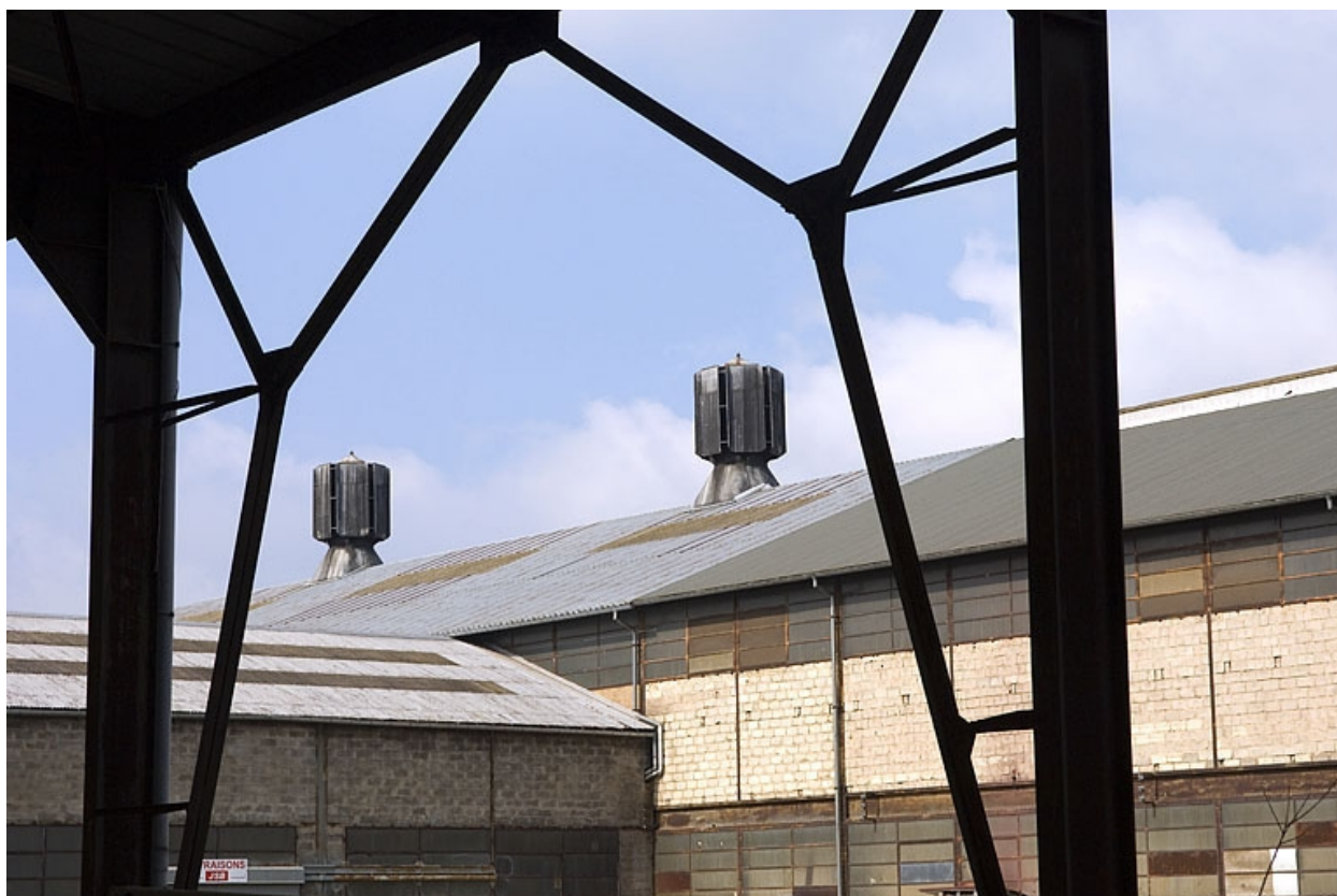
Atelier de fabrication. Cheminées d'extraction.
