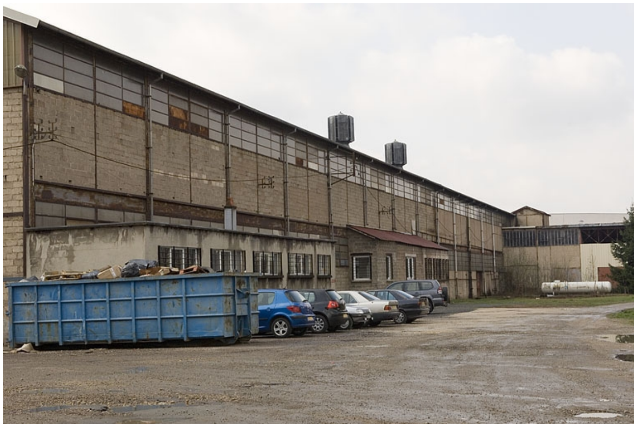
Façade nord de l'atelier de fabrication.
