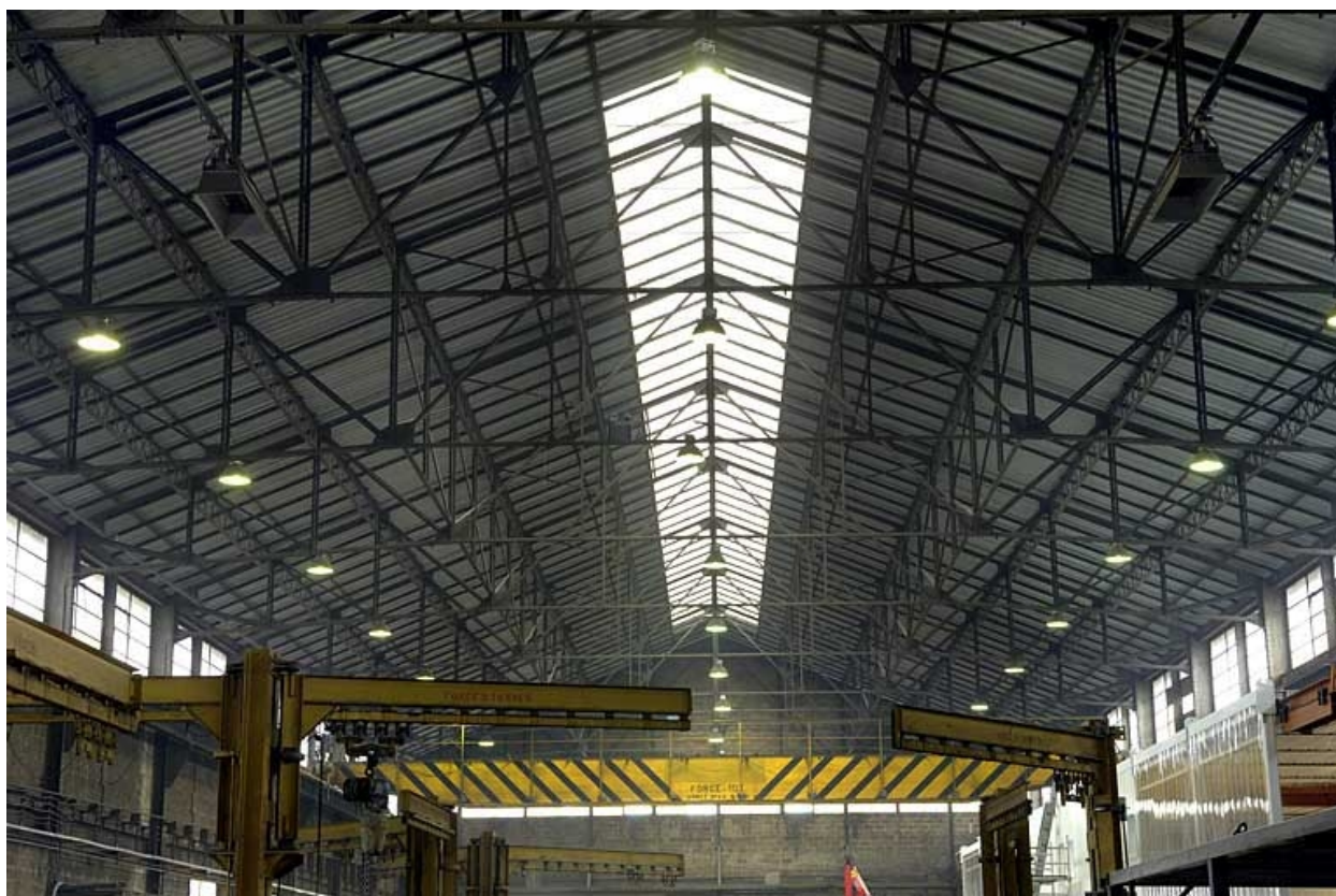
Atelier de fabrication. Charpente et couverture métallique.
