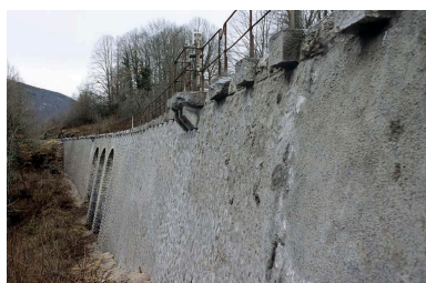
Vue d'ensemble en enfilade, depuis le côté Andelot-en-Montagne (nord) Phot. Yves Sancey IVR43_20053900664ZA
