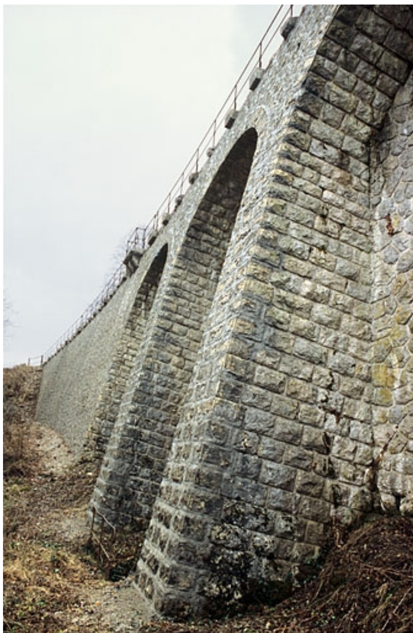
Talus du mur au niveau des arcades.
