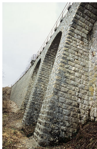
Talus du mur au niveau des arcades. Phot. Yves Sancey IVR43_20053900665ZA
