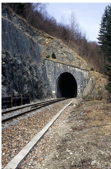
Tunnel : tête sud-ouest (côté La Cluse). Phot. Yves Sancey IVR43_20053900387ZA
