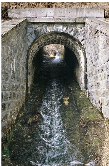
Pont : vue d'ensemble, depuis le sud (aval). Phot. Yves Sancey IVR43_20053900395ZA
