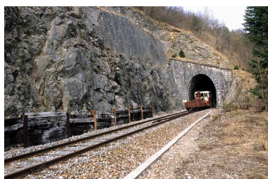
Tunnel : tête sud-ouest (côté La Cluse), avec draisine. Phot. Yves Sancey IVR43_20053900389ZA
