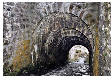
Pont : voûte appareillée en rouleaux à ressauts, depuis le nord (amont). Phot. Yves Sancey IVR43_20053900393ZA
