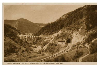
Morez - Les Viaducs et la Grande Roche, milieu 20e siècle. Phot. IVR43_20073900021NUCA
