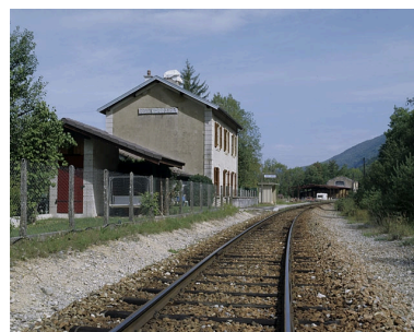
Vue d'ensemble, depuis la voie côté La Cluse (sud). Phot. Yves Sancey IVR43_20043900515XA
