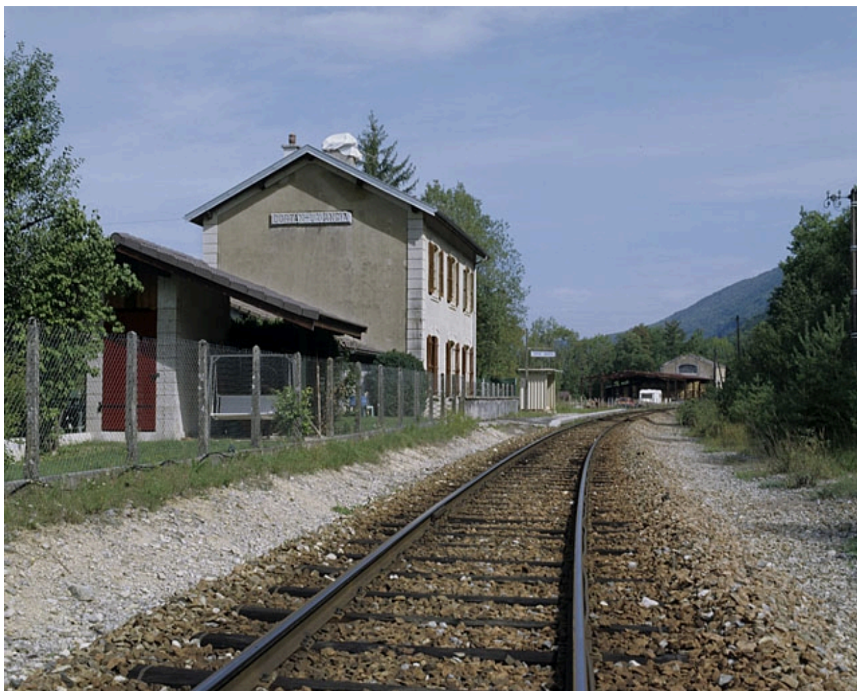
Vue d'ensemble, depuis la voie côté La Cluse (sud).
