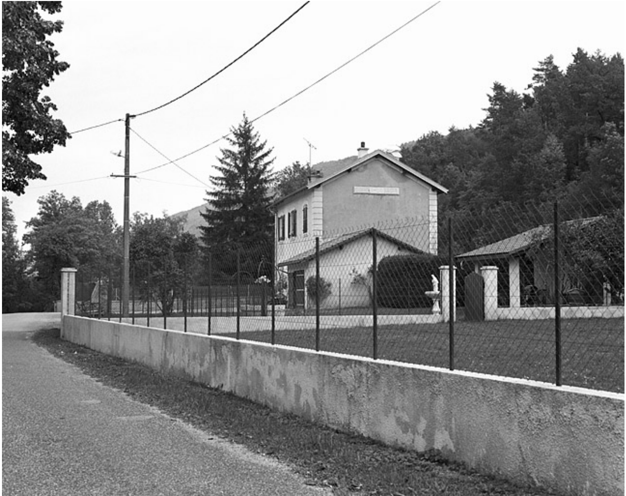
Vue d'ensemble, depuis la route au sud-ouest.
