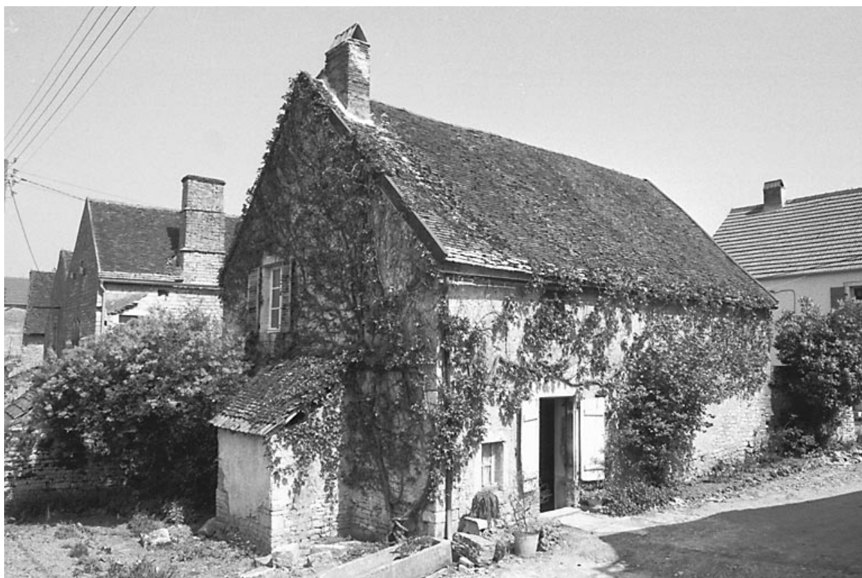
Maison située Au Village.
