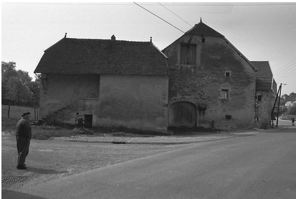
Maison située Au Village.
