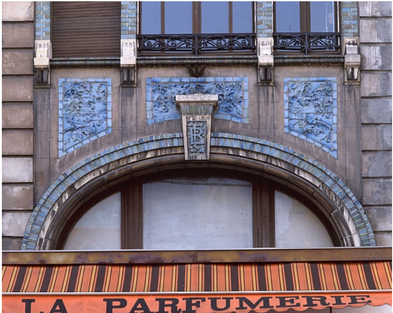
Façade sur la rue Cuvier, détail.
