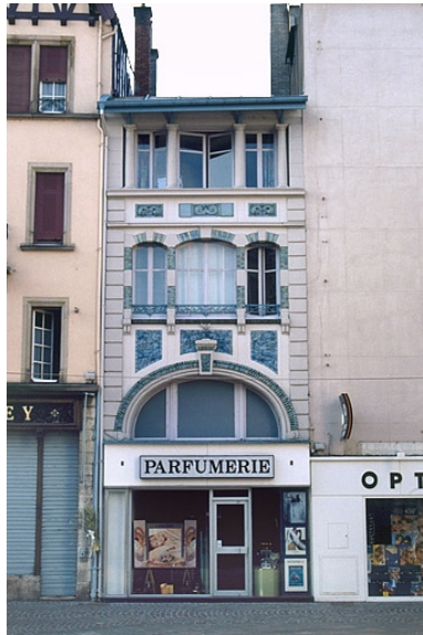
Façade sur la rue Cuvier. Phot. Jérôme Mongreville IVR43_19972500054ZA
