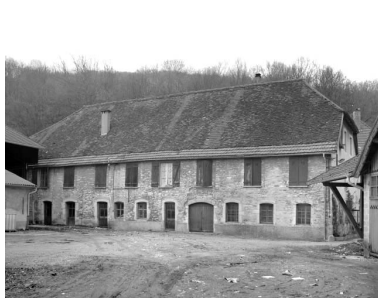
Moulin à papier (?), puis logements d'ouvriers. Phot. Jérôme Mongreville IVR43_19973900497X
