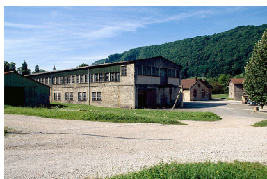
Vue depuis l'entrée. Phot. Jérôme Mongreville IVR43_19973901073ZA
