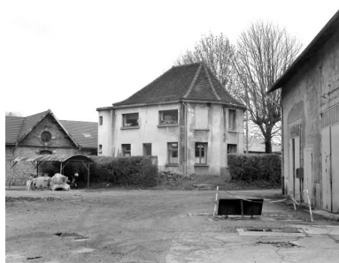
Façade postérieure des bureaux. Phot. Jérôme Mongreville IVR43_19973900490X
