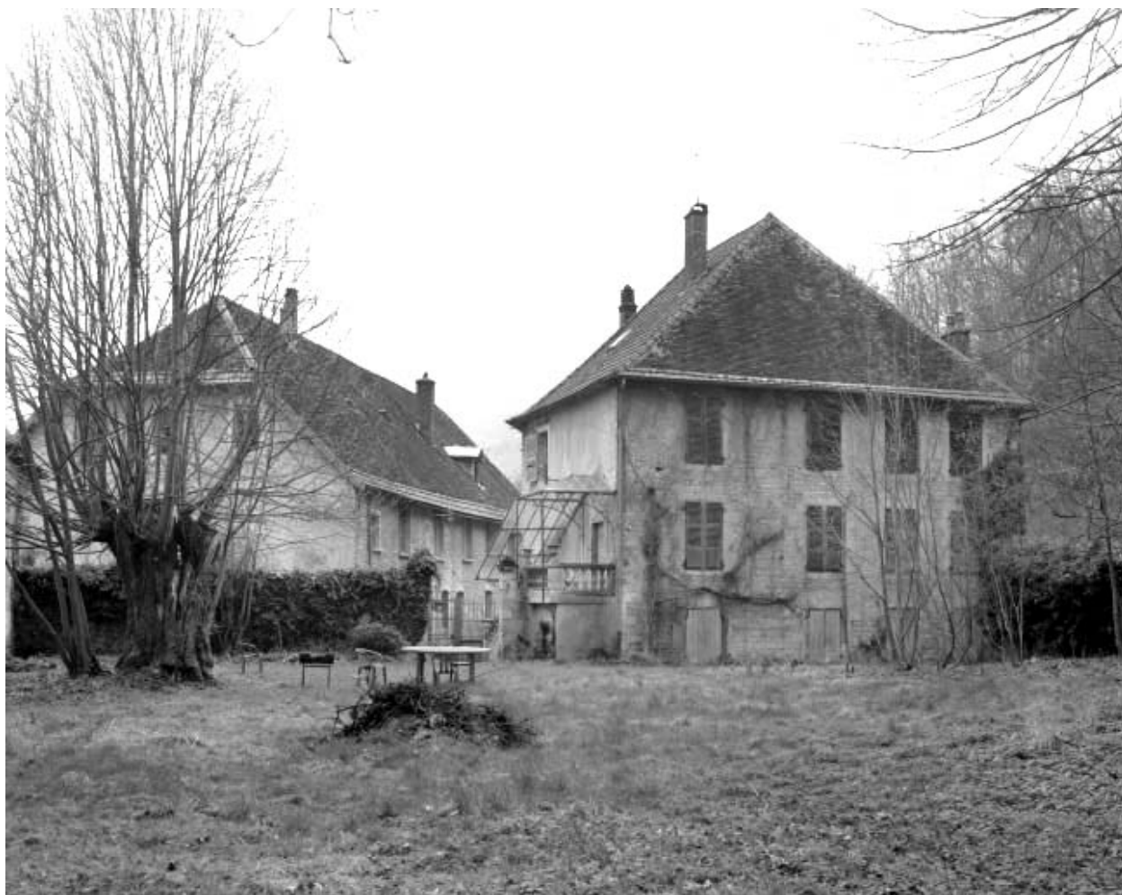
MOulin à papier (?), puis logement d'ouvriers, et logement patronal.
