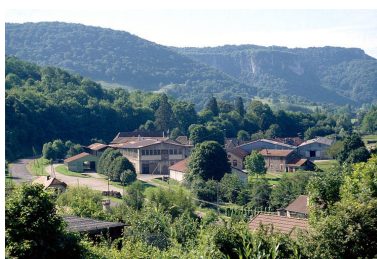
Vue générale depuis le nord. Phot. Jérôme Mongreville IVR43_19973901071ZA
