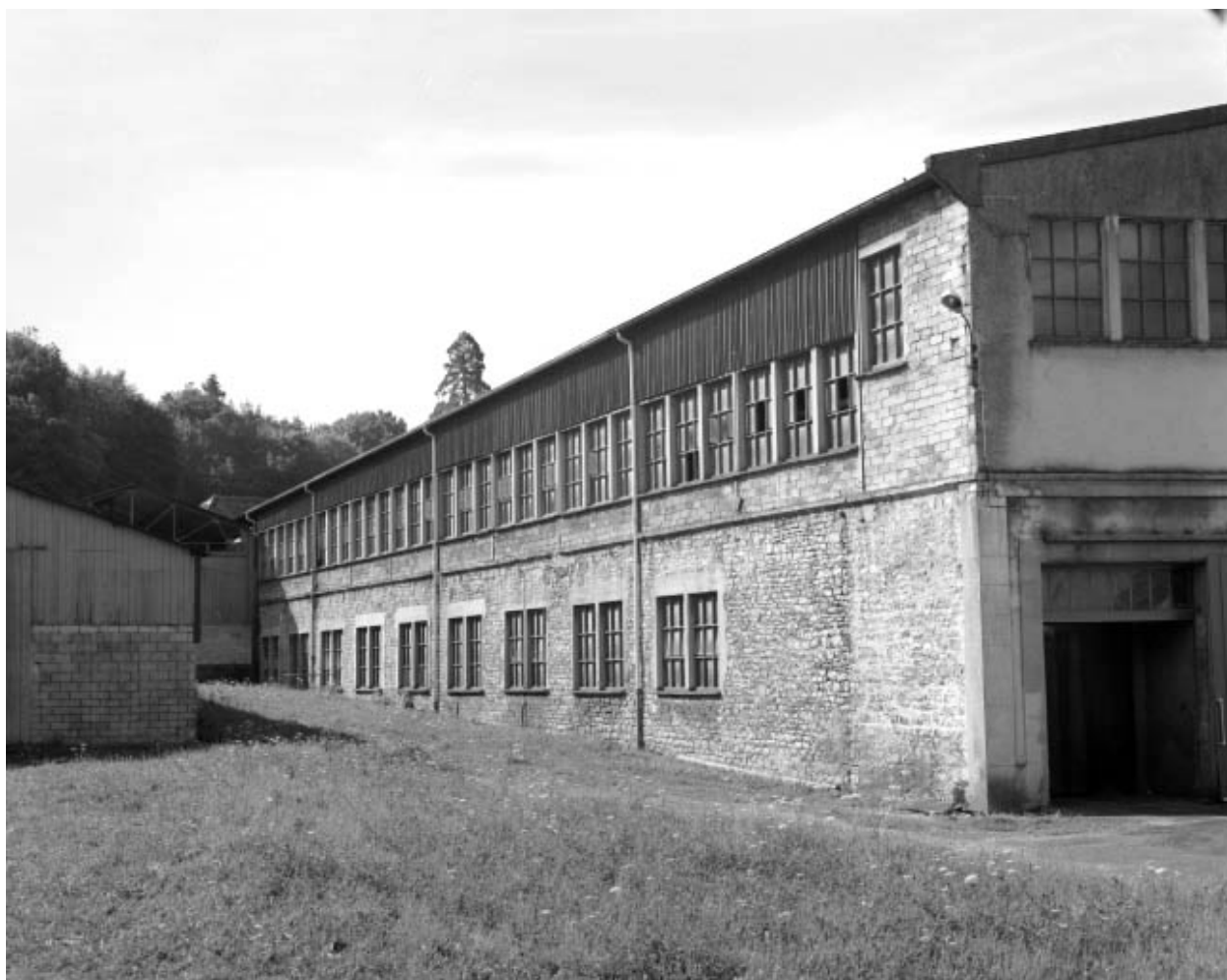
Atelier de fabrication est.
