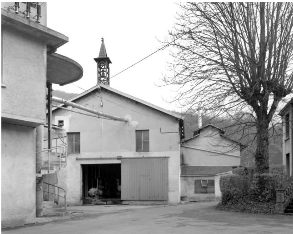
Atelier de fabrication et chaufferie.
