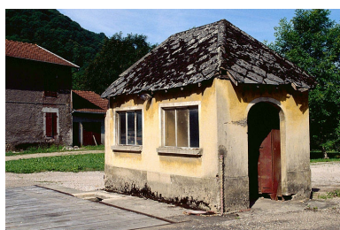
Poste du pont bascule.
