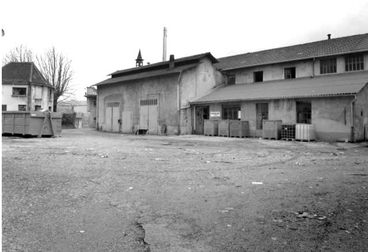
Vue de la seconde cour. De gauche à droite : bureaux, chaufferie et laboratoire.
