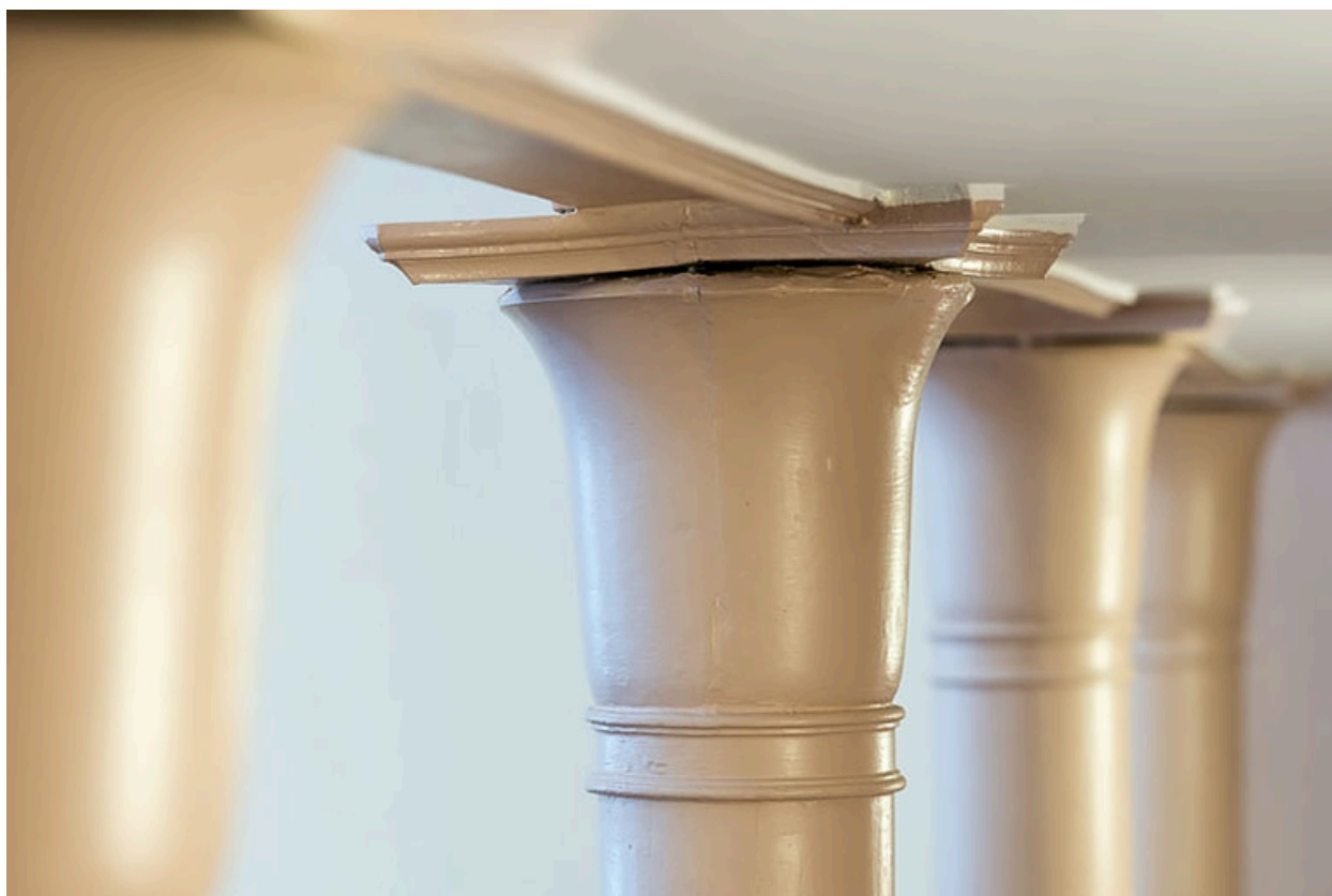
Aile nord, salle de spectacle : chapiteaux de colonnes du rez-de-chaussée.
