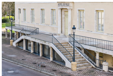
Aile nord, façade antérieure : escalier.
