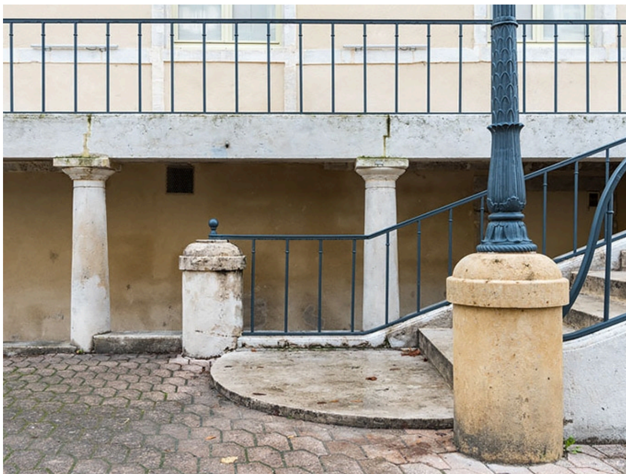
Aile nord, façade antérieure : départ de l'escalier et colonnes doriques supportant le balcon.
