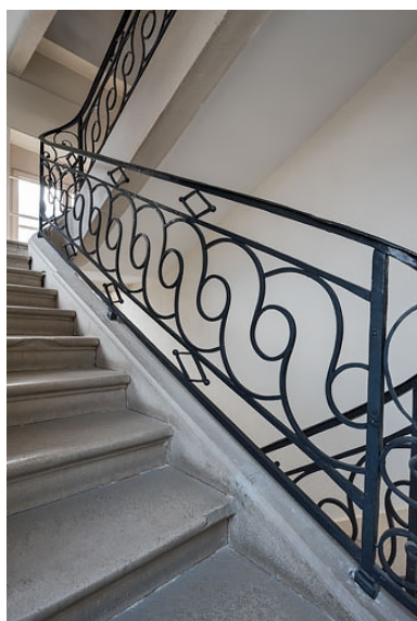
Aile nord : rampe d'appui de l'escalier dans l'angle sud-ouest. Phot. Pierre-Marie Barbe-Richaud IVR26_20212100415NUC4A
