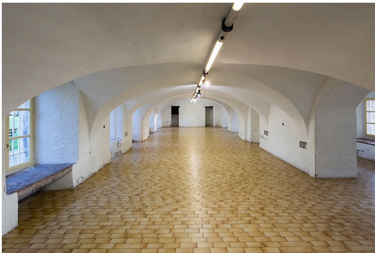
Aile est : salle voûtée au rez-de-chaussée ("salle des Bénédictines").
