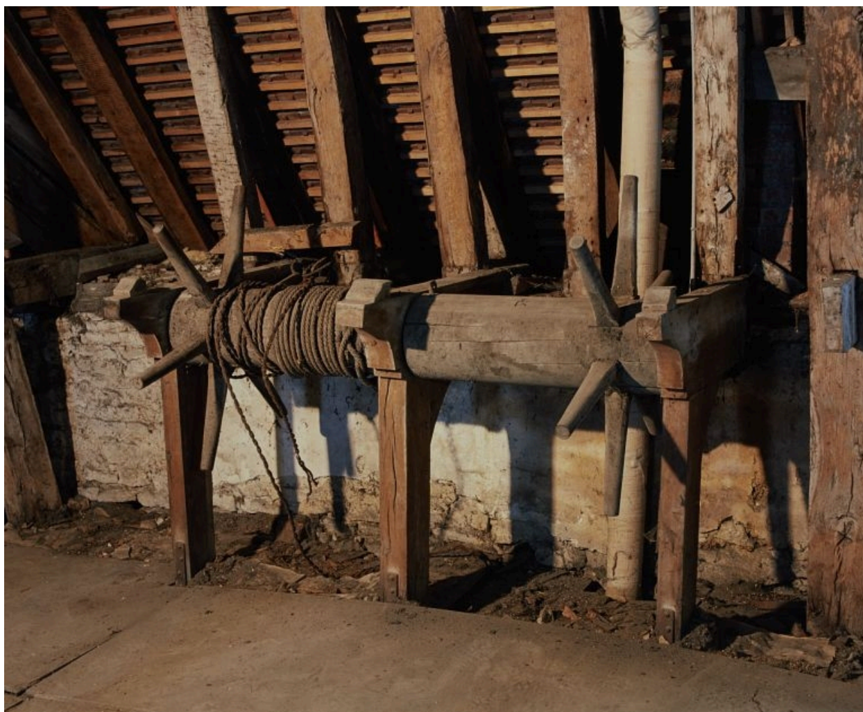
Salle de spectacle en 1996 : mécanisme du lustre (dans le comble). Ce mécanisme a été supprimé après 1996.
