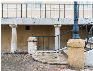
Aile nord, façade antérieure : départ de l'escalier et colonnes doriques supportant le balcon. Phot. Pierre-Marie Barbe-Richaud IVR26_20212100396NUC4A
