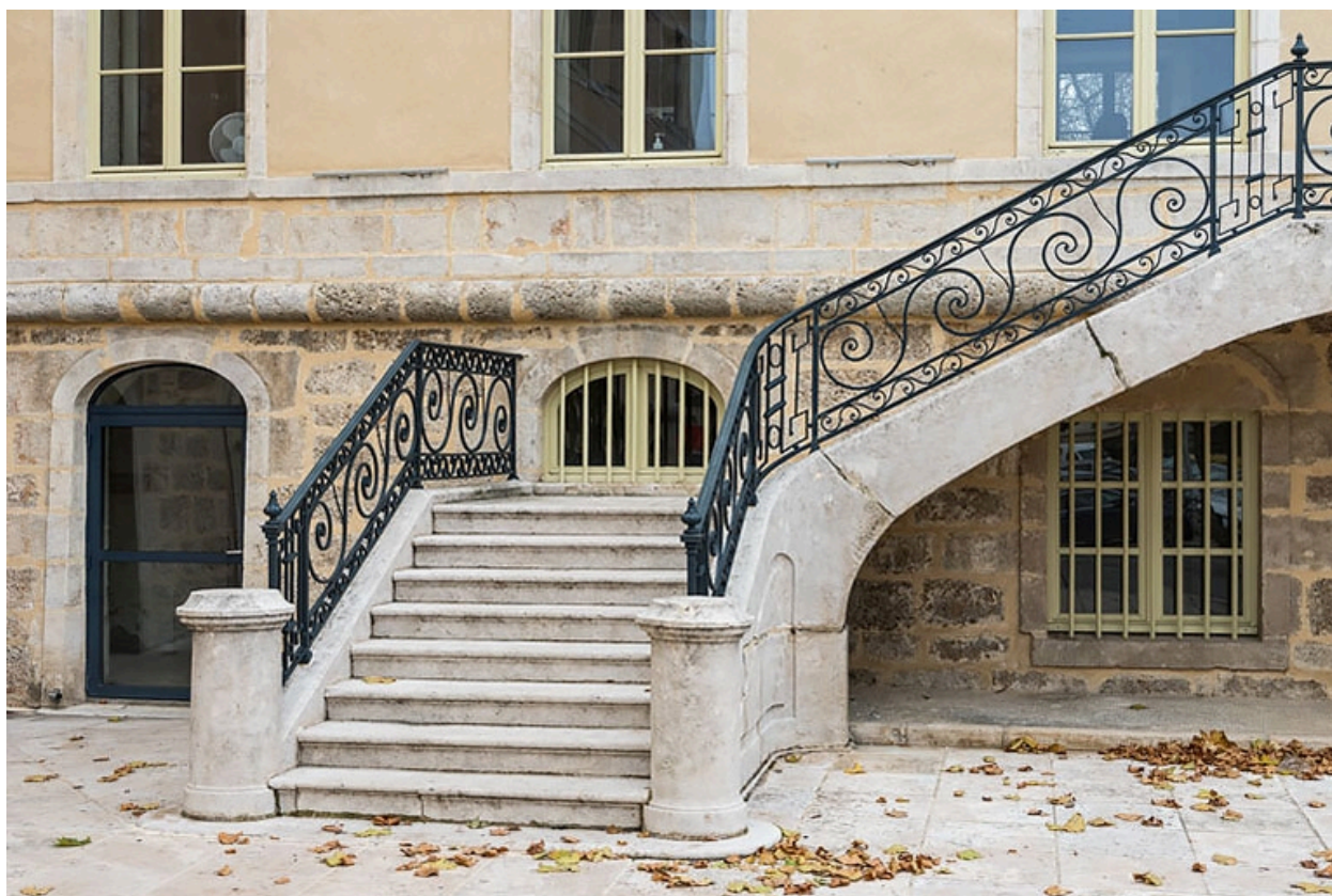
Aile est, façade antérieure : escalier, volée de gauche.
