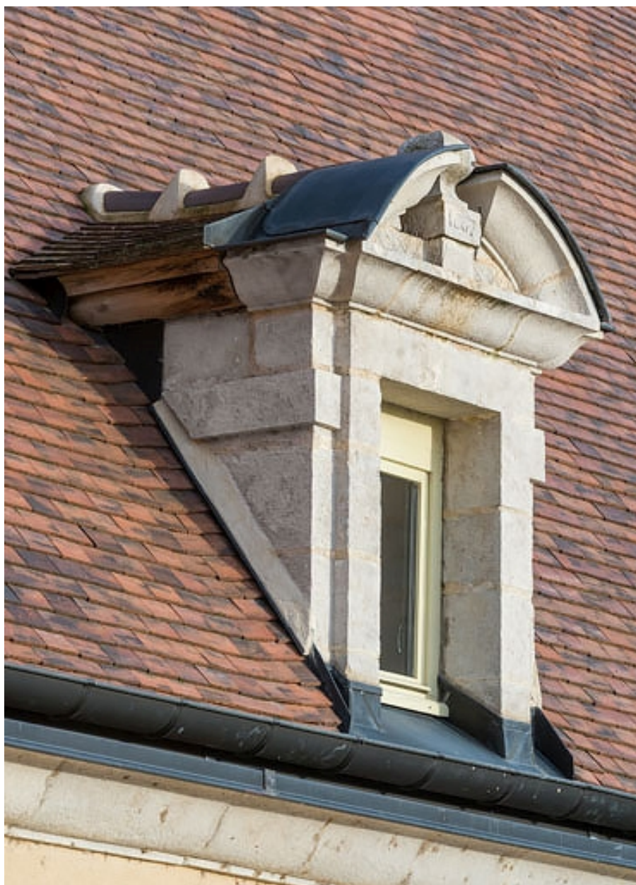
Aile est, façade antérieure : lucarne centrale.
