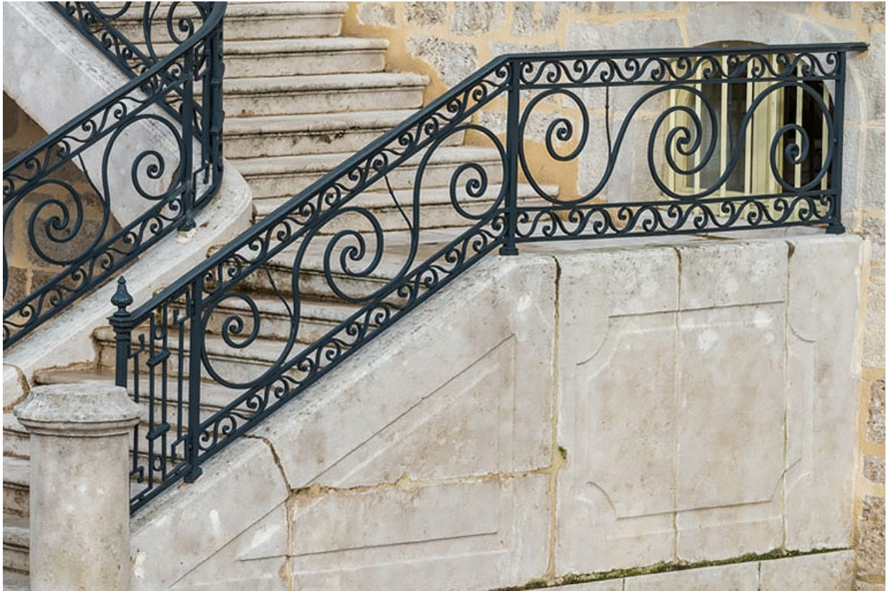
Aile est, façade antérieure : escalier, rampe d'appui de la volée de droite.
