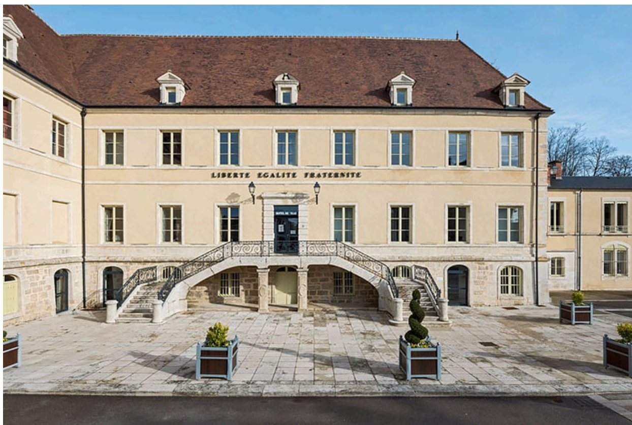
Aile est : façade antérieure.
