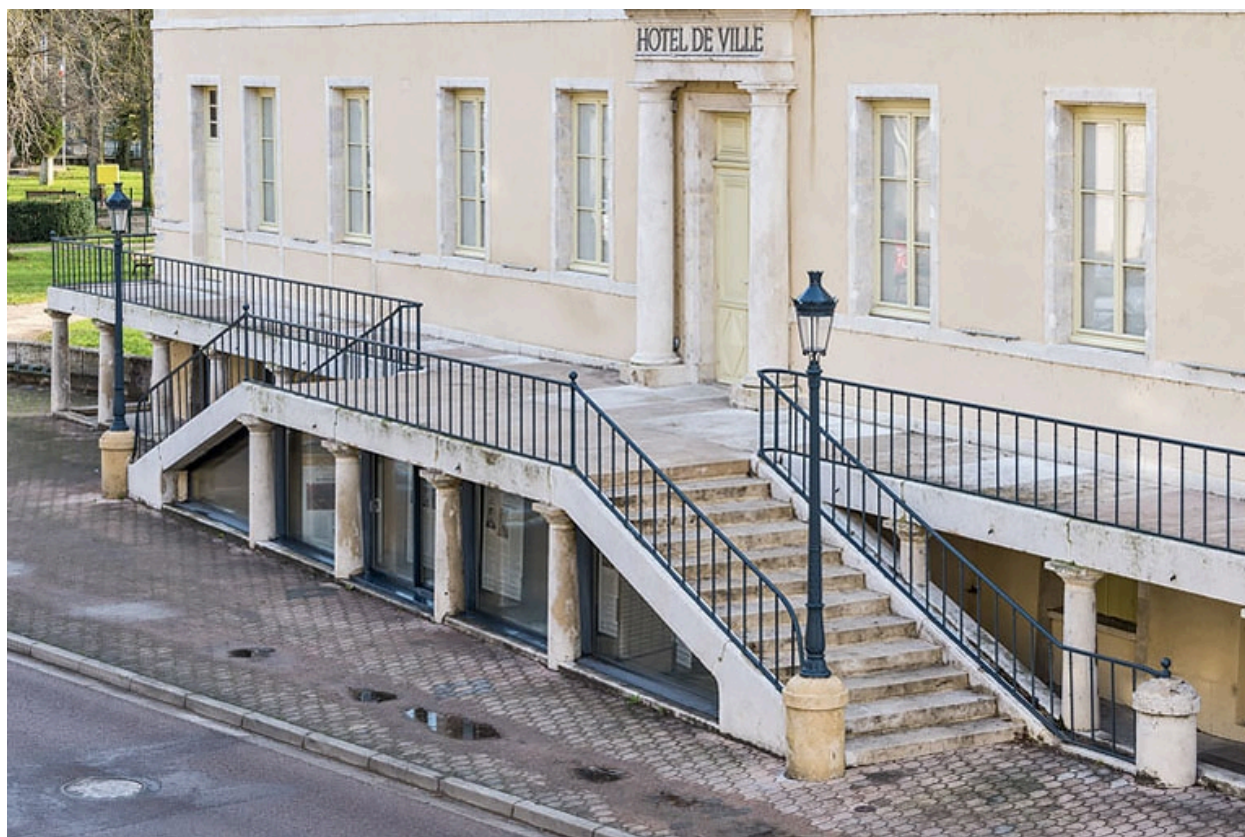
Aile nord, façade antérieure : escalier.
