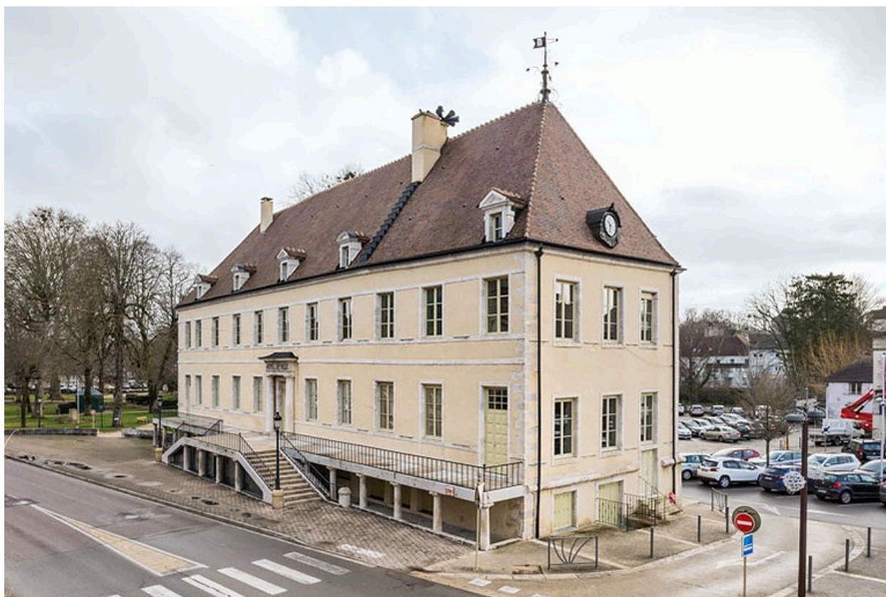
Vue d'ensemble, depuis l'ouest : aile nord.
