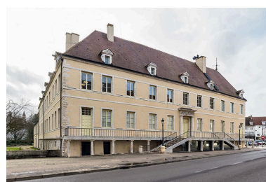
Aile nord : façade antérieure, de trois quarts gauche. Phot. Pierre-Marie Barbe-Richaud IVR26_20212100395NUC4A
