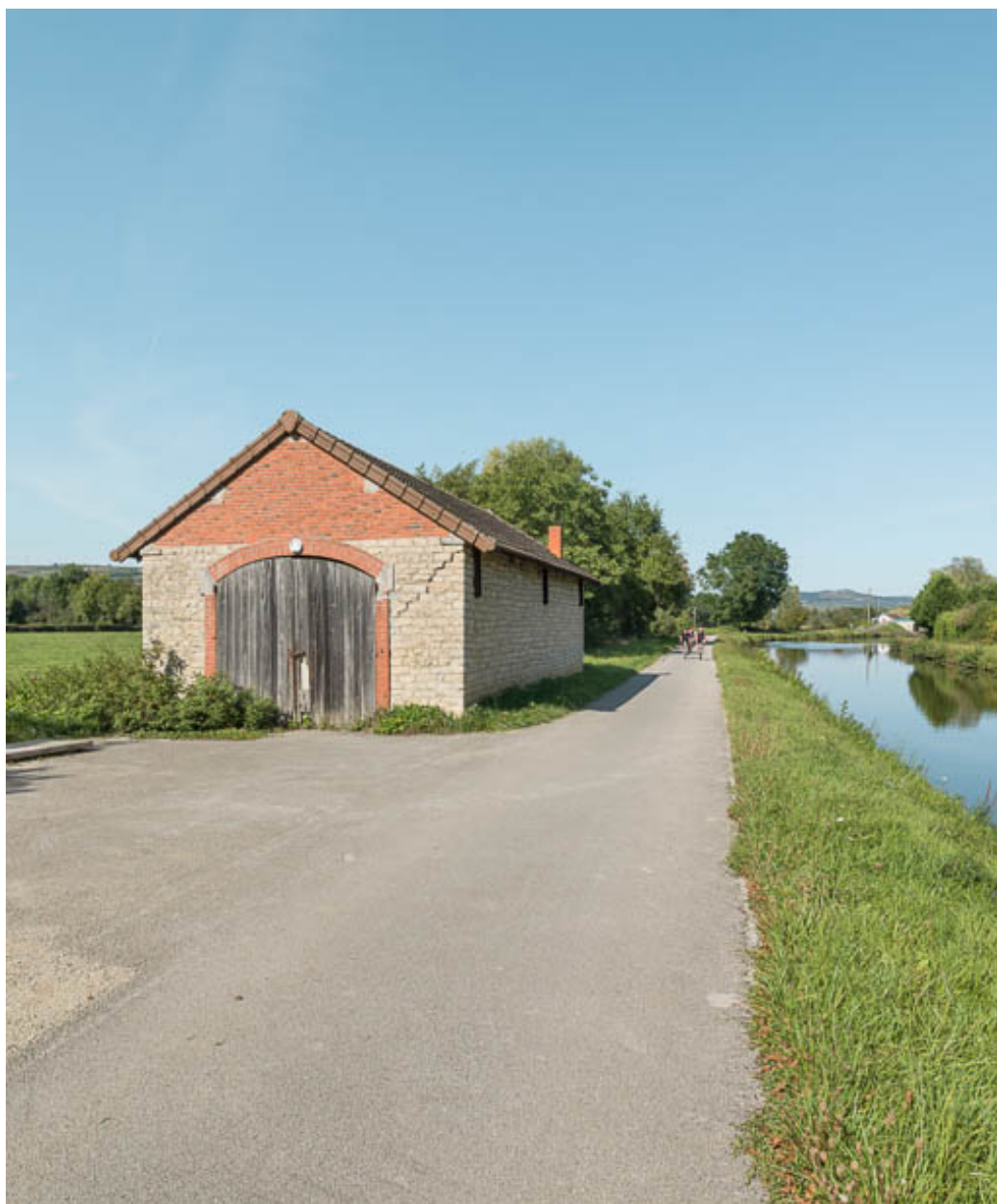
Vue d'ensemble de la remise, rive gauche.
