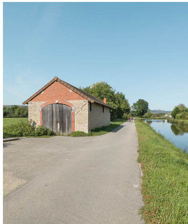
Vue d'ensemble de la remise, rive gauche.
