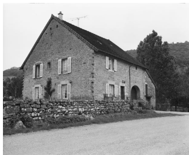
Ferme située au lieudit Billin : vue d'ensemble.
