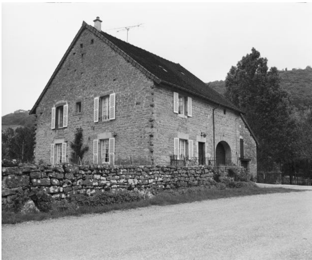
Ferme située au lieudit Billin : vue d'ensemble.
