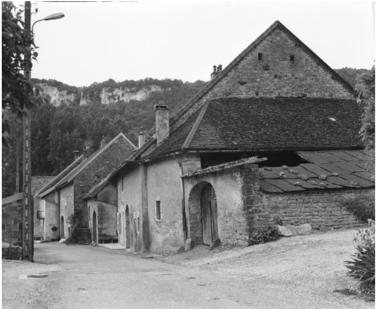
Ferme située rue du Moulin : vue d'ensemble.
