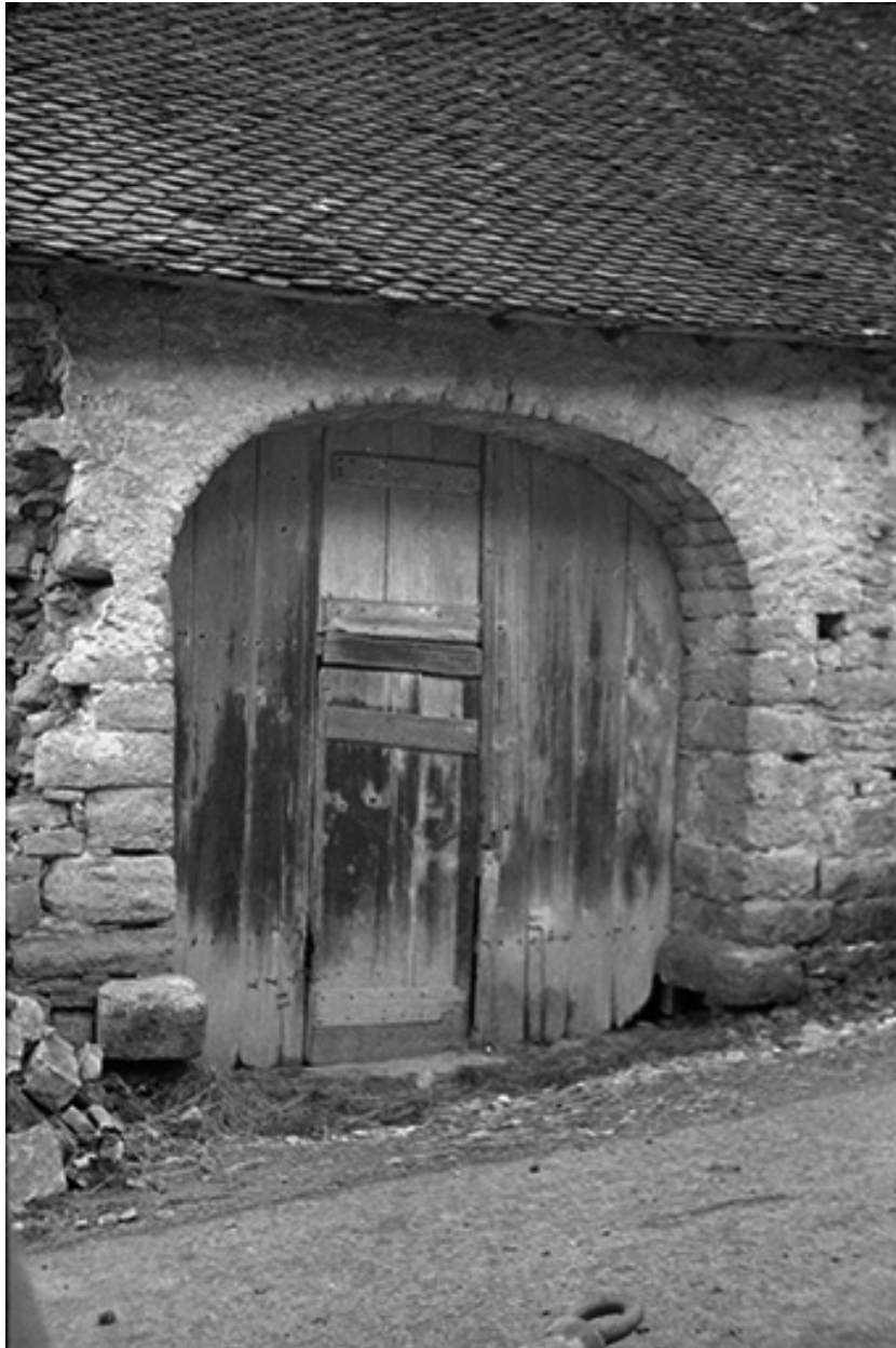
Ferme cadastrée 1965 AD : porte de grange.
