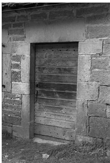
Ferme cadastrée 1965 AD : porte extérieure. Phot. F. Pernin IVR43_19743900061Z
