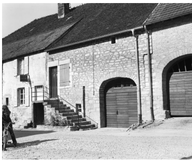
Ferme située au lieudit Billin : façade antérieure.
