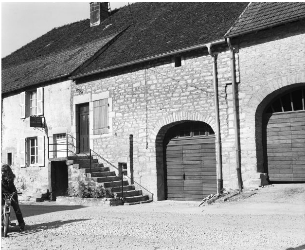
Ferme située au lieudit Billin : façade antérieure.
