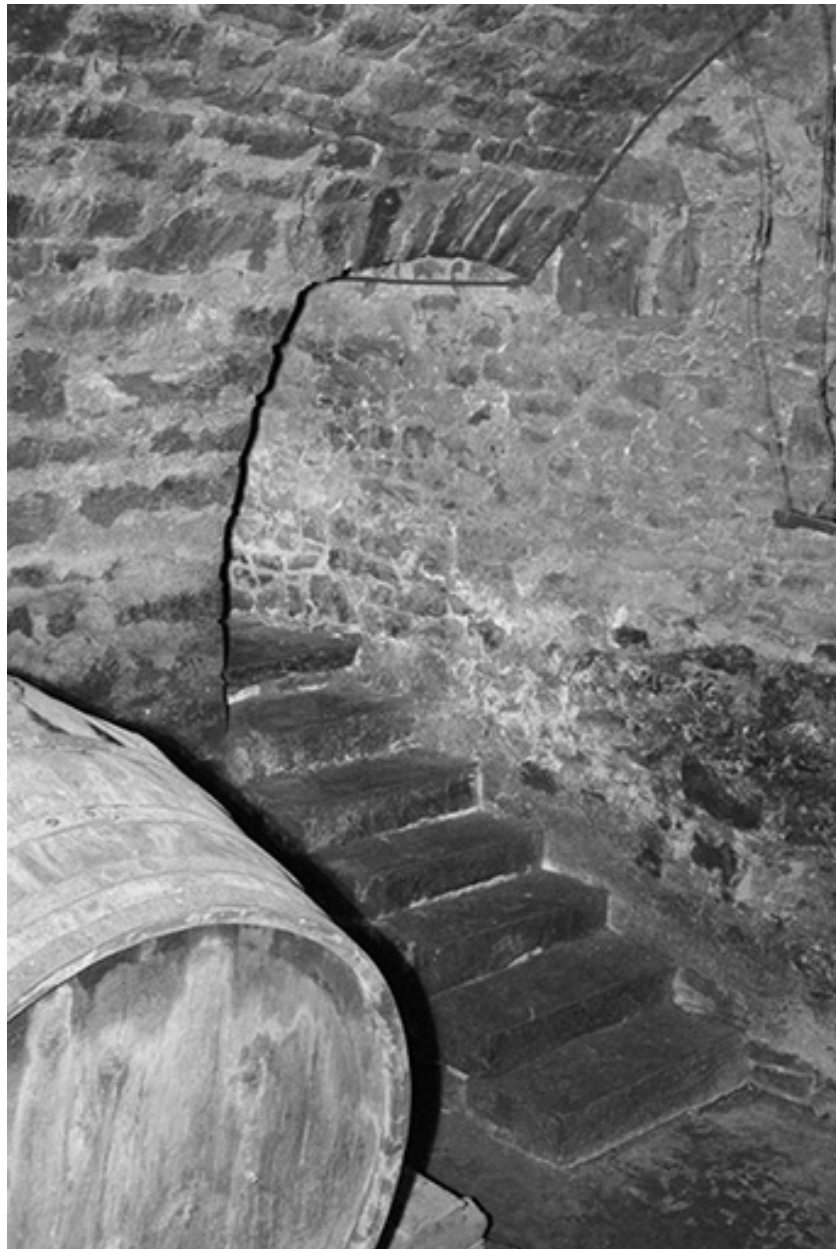
Ferme cadastrée 1965 AD : escalier de la cave.
