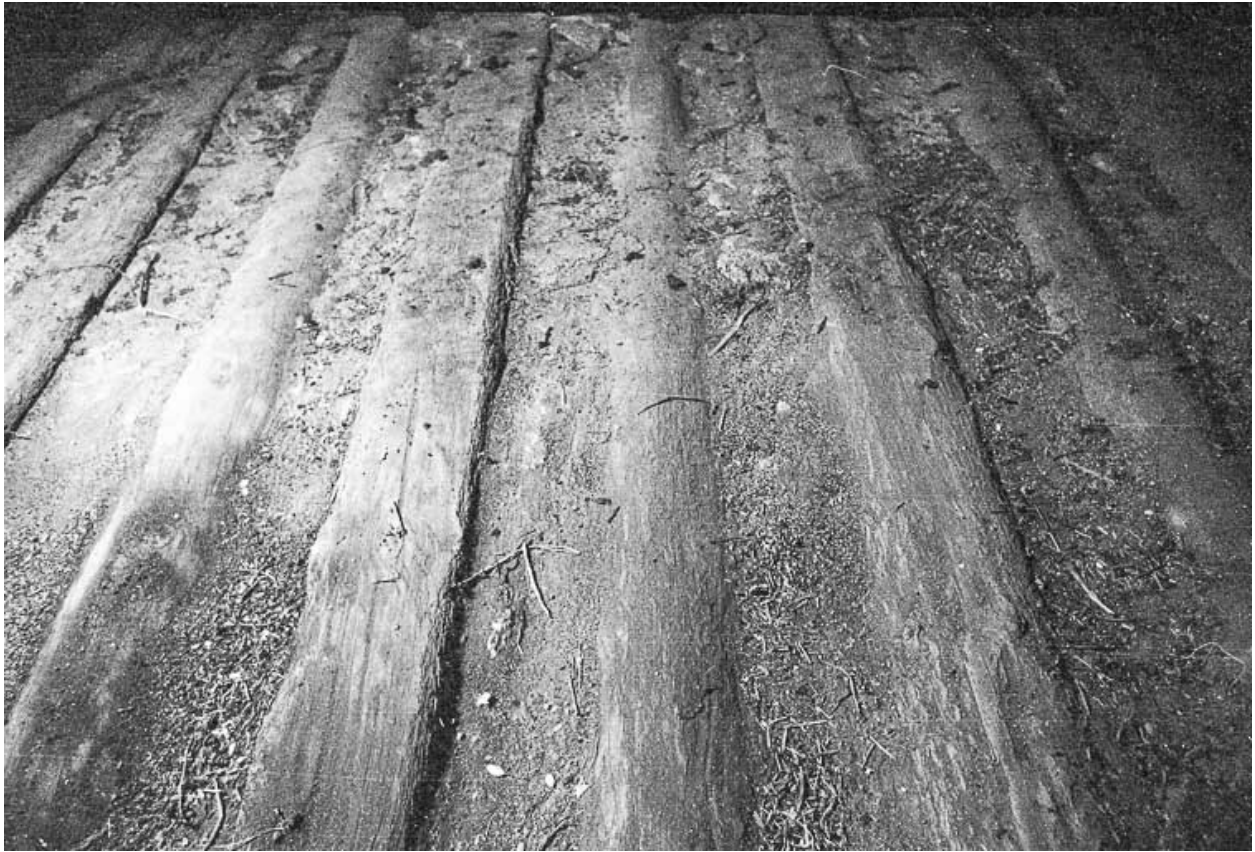
Ferme cadastrée 1965 AD : détail du plafond.
