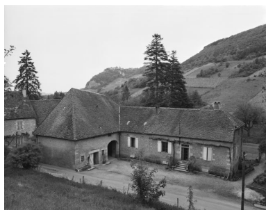
Ferme située route de la Vallée : façade antérieure. Phot. Yves Sancey IVR43_19813900207X
