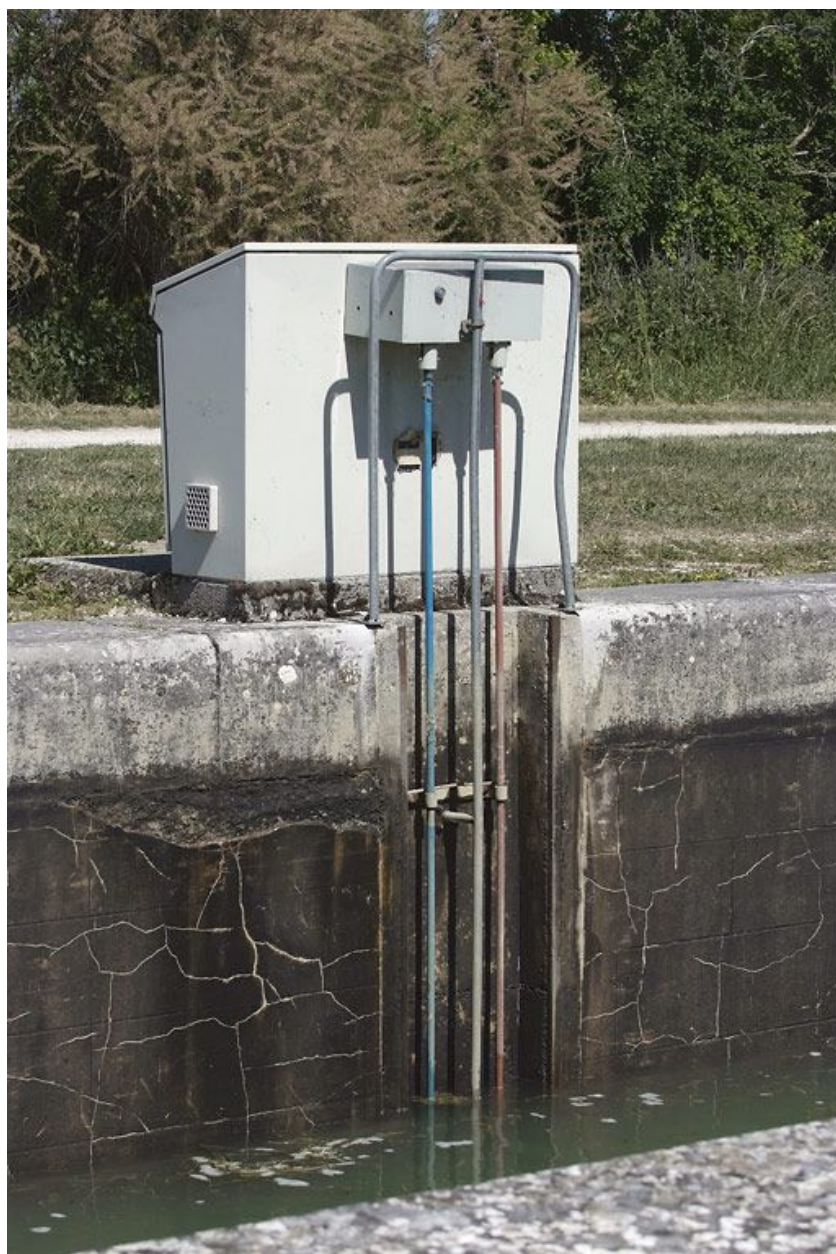
Détail d'un élément du système d'automatisation de l'écluse : la table de commande placée sur le bord du sas.
