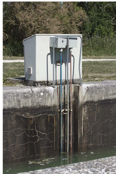
Détail d'un élément du système d'automatisation de l'écluse : la table de commande placée sur le bord du sas. Phot. Thierry Kuntz IVR26_20112103071NUC2A
