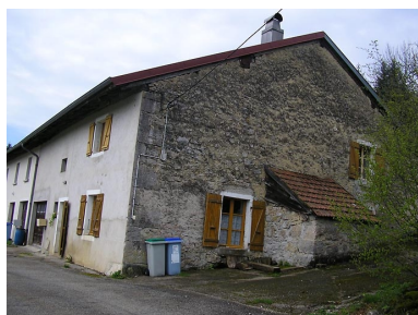
Ferme située au lieu-dit Ladaval. Phot. Marie-Pierre Reynet IVR43_20083900345NUC1A
