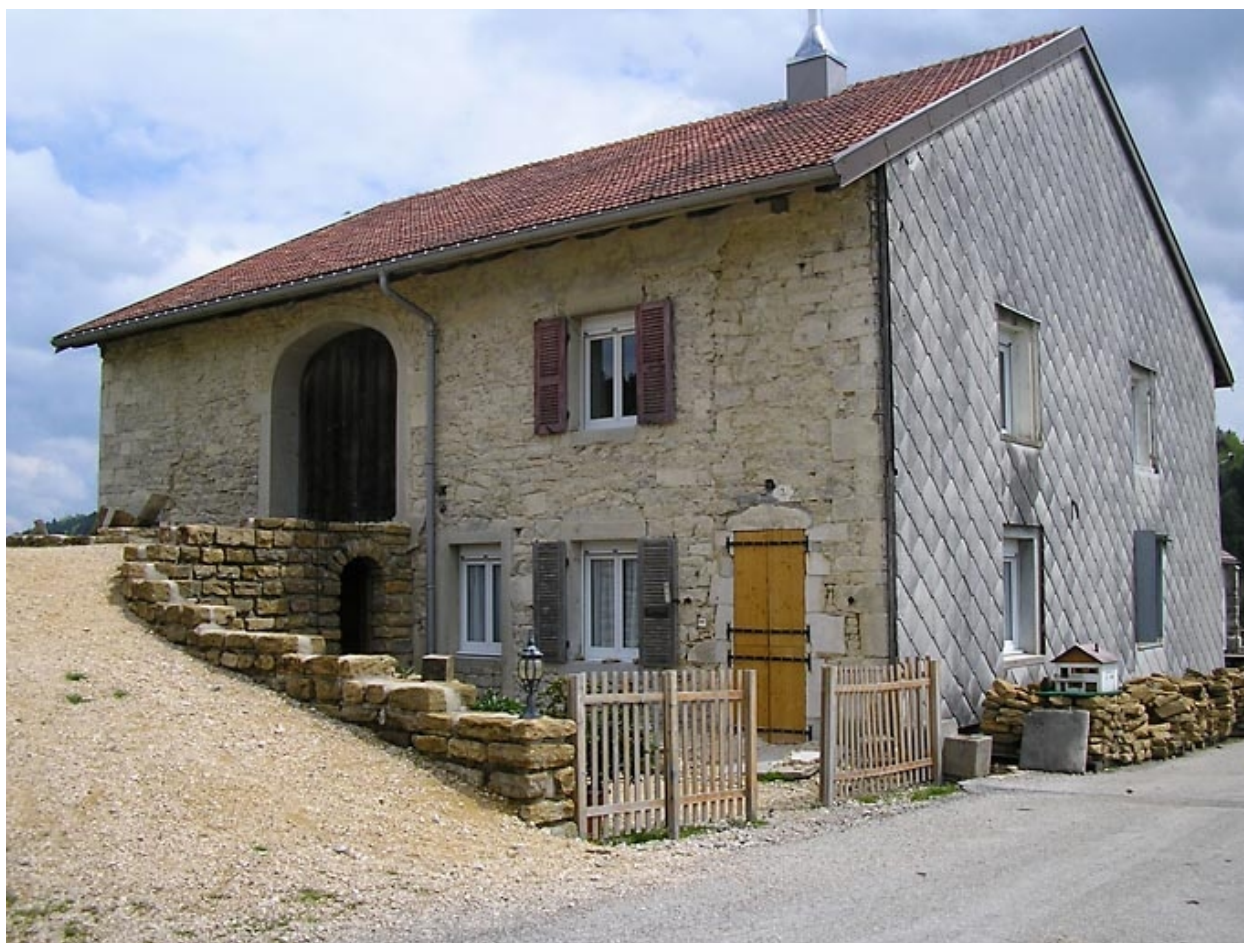
Ferme située 7 rue de la Chapelle.
