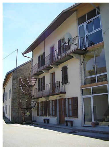
Maison située 10 rue du Haut. Phot. Marie-Pierre Reynet IVR43_20083900363NUC1A
