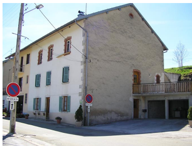
Ferme située 4 rue du Haut. Phot. Marie-Pierre Reynet IVR43_20083900364NUC1A
