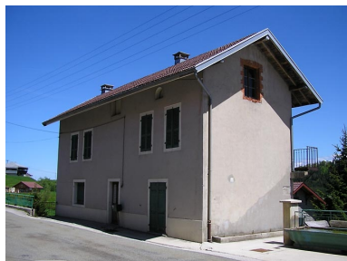
Maison située 5 rue du Haut. Phot. Marie-Pierre Reynet IVR43_20083900362NUC1A
