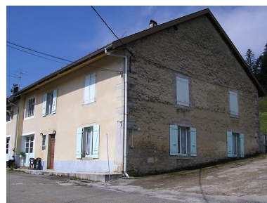
Ferme située au lieu-dit Ladaval. Phot. Marie-Pierre Reynet IVR43_20083900348NUC1A
