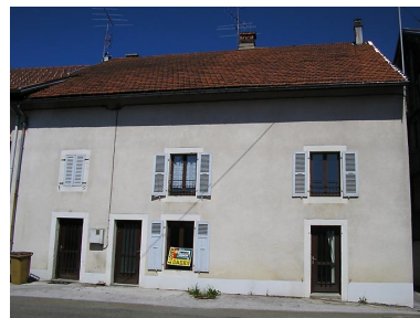
Ferme située 12 rue du Haut. Phot. Marie-Pierre Reynet IVR43_20083900359NUC1A
