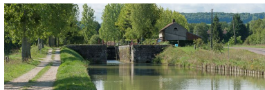
Vue du site d'écluse depuis l'aval. Phot. Pierre-Marie Barbe-Richaud IVR26_20112103830NUC4AQ
