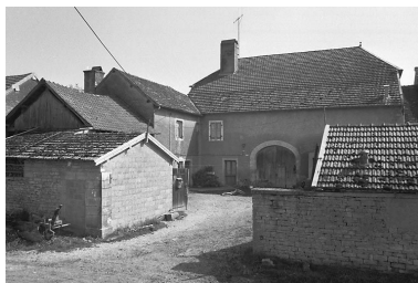
Ferme située 9 Grande Rue. Phot. Jean-Marie NEPASUTILISERBaverel IVR43_19807000387Z
