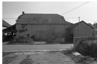
Ferme située 15 Grande Rue. Phot. Jean-Marie NEPASUTILISERBaverel IVR43_19807000388Z
