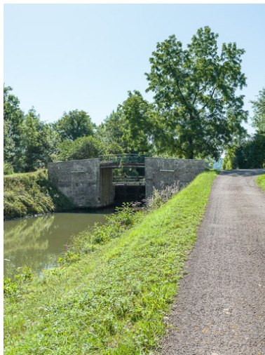
Vue du pont.
