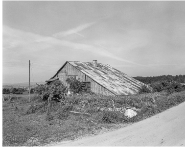
Vue de trois quarts. Phot. Dominique Dominguez IVR43_19792500897X
