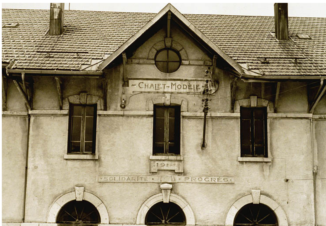
Façade antérieure : partie haute de l'avant-corps central.
