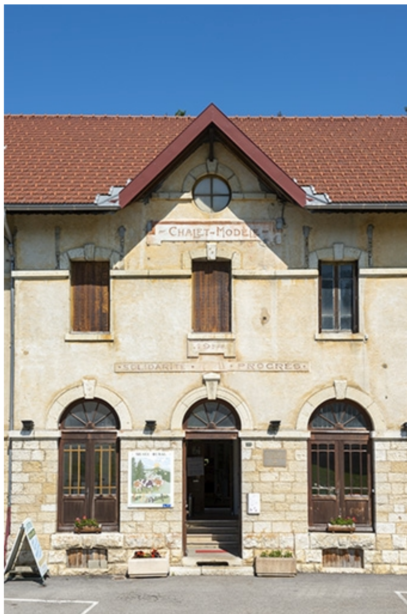
Partie centrale de la façade antérieure.
