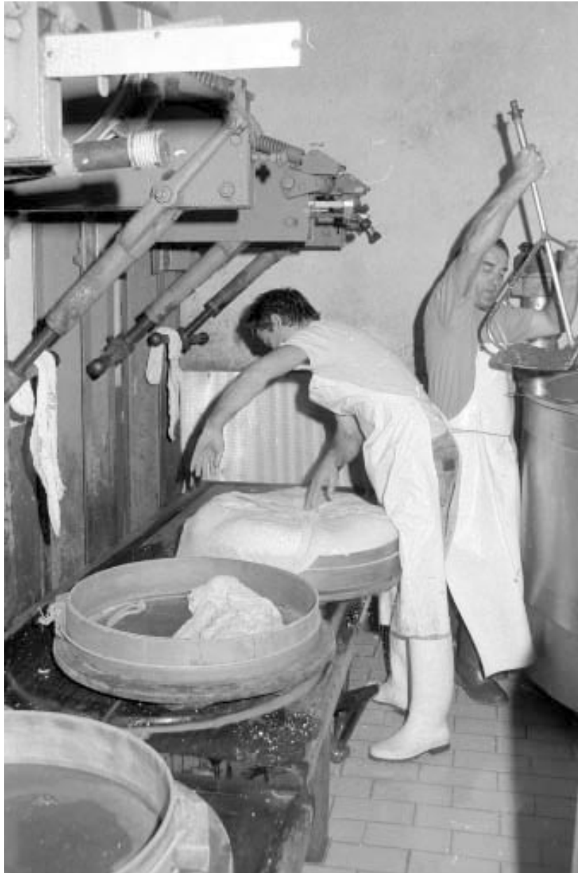
Fabrication du comté : pliage de la toile.
