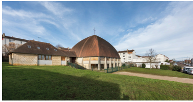
Centre paroissial. Vue d'ensemble de trois quarts. Phot. Pierre-Marie Barbe-Richaud IVR26_20258900022NUC4A
