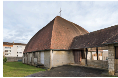
Eglise. Vue de trois quarts depuis l'est. Phot. Pierre-Marie Barbe-Richaud IVR26_20258900019NUC4A
