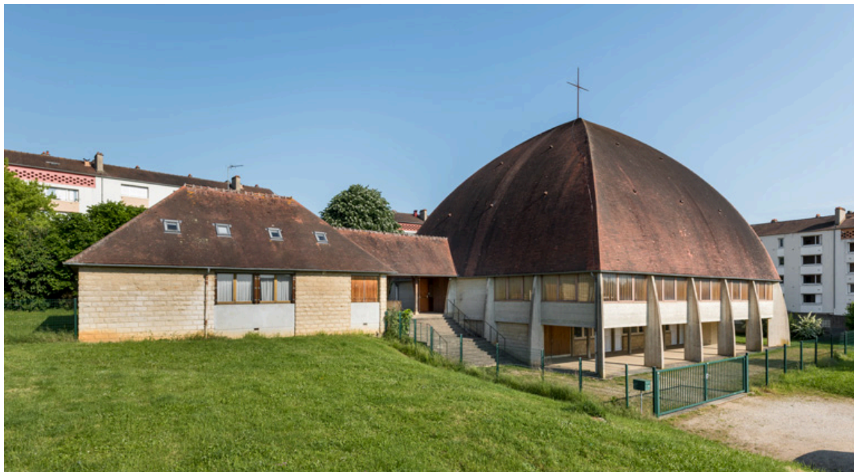
Centre paroissial. Vue d'ensemble.
