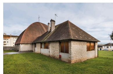
Centre paroissial. Vue de trois- quarts depuis le sud-ouest. Au premier plan, le presbytère.
