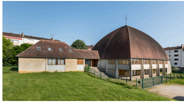
Centre paroissial. Vue d'ensemble. Phot. Pierre-Marie Barbe-Richaud IVR26_20258900079NUC4A
