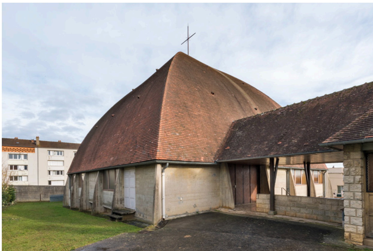
Eglise. Vue de trois quarts depuis l'est.
