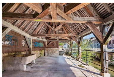
Vue de la charpente, depuis le sud. Phot. Jérôme Mongreville IVR43_20233900237NUC4A
