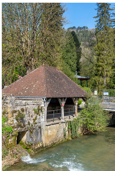
Vue depuis le sud-est. Phot. Jérôme Mongreville IVR43_20233900234NUC4A
