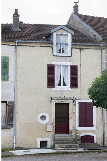
Façade antérieure. Phot. Jérôme Mongreville IVR43_20127000461NUC4A
