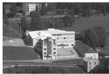
Vue d'ensemble plongeante sur l'usine, depuis l'ouest. Phot. Laurent Poupard IVR43_19913901557Z
