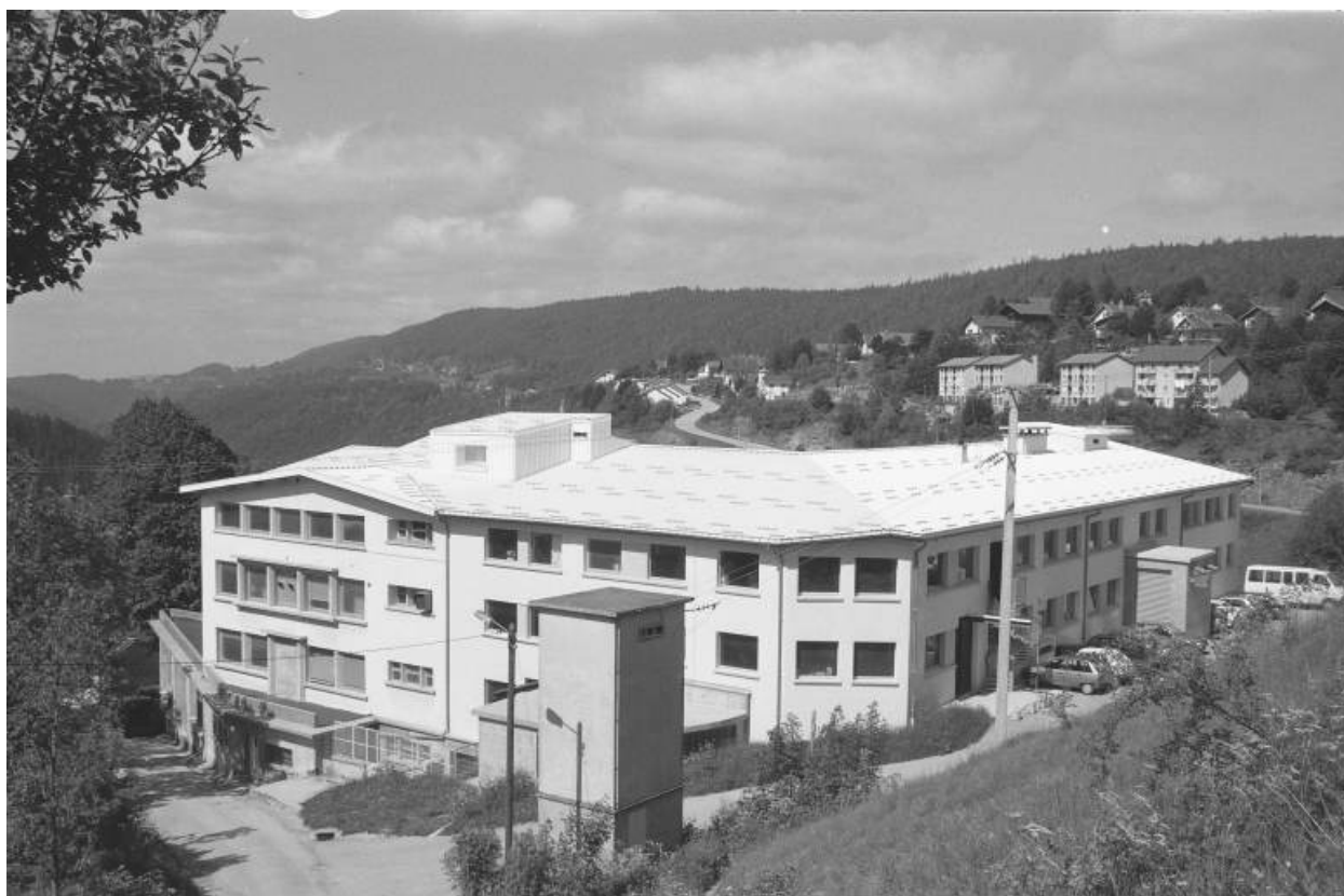
Façade postérieure des ailes nord et est.
