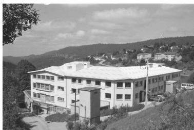
Façade postérieure des ailes nord et est. Phot. Laurent Poupard IVR43_19913901560Z
