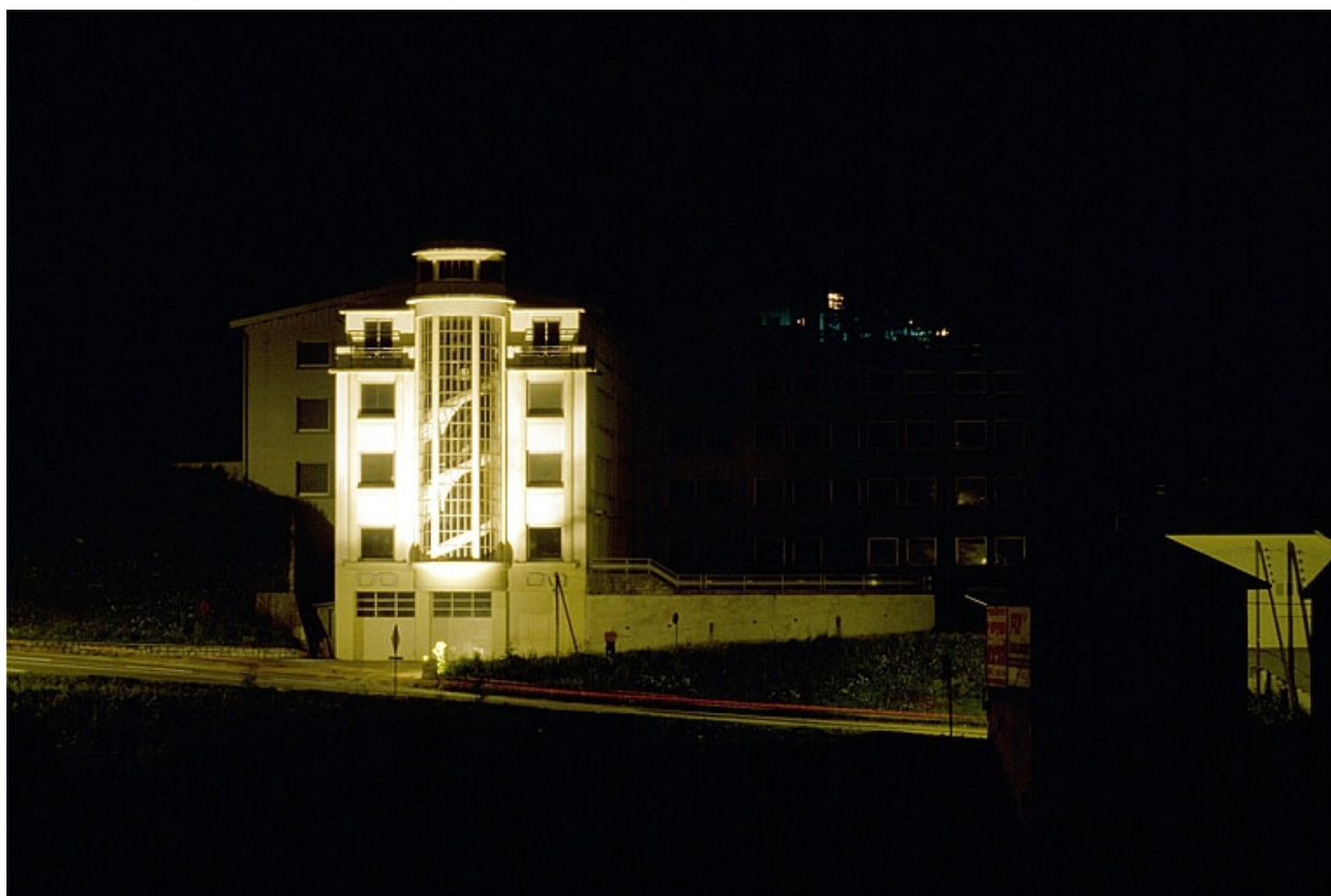
Cage d'escalier demi-hors-oeuvre, de nuit.
