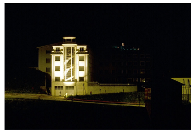
Cage d'escalier demi- hors-oeuvre, de nuit.
