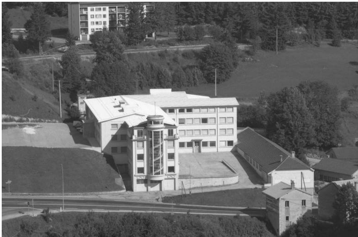
Vue d'ensemble plongeante sur l'usine, depuis l'ouest.
