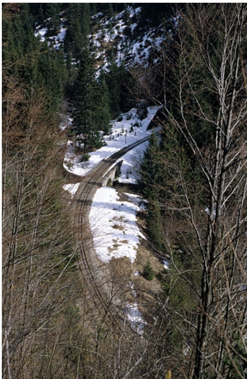
2 ponts ferroviaires (voie ferrée Andelot - La Cluse) situé au lieudit Le Caton.
