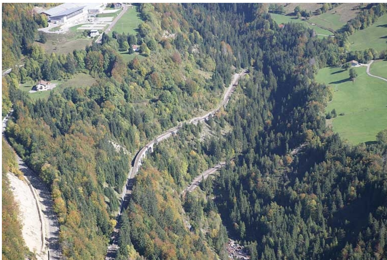
Viaduc de Romand (voie ferrée Andelot - La Cluse).
