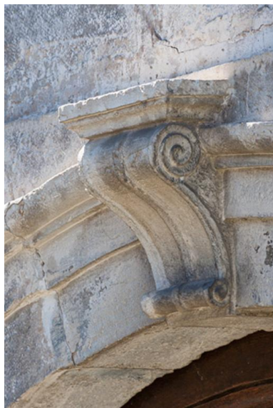
Détail de la porte Phot. Jérôme Mongreville IVR43_20137000262NUCA
