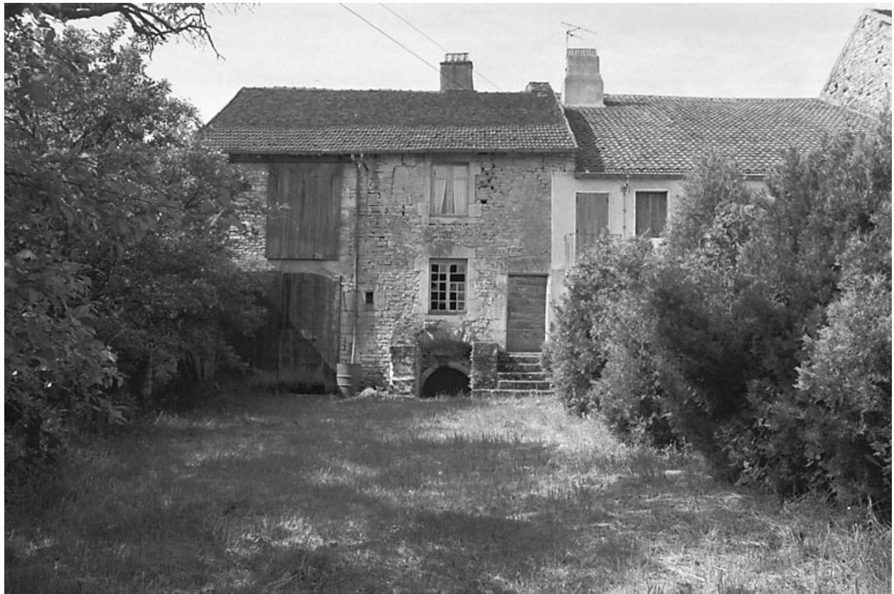
Façade antérieure sur cour.
