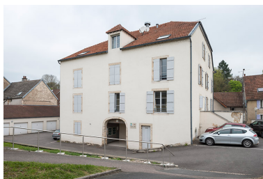
Façade postérieure. Phot. Jérôme Mongreville IVR43_20177000722NUC4A
