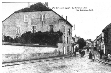
L'immeuble au début de la Grande rue, carte postale. Autr. auteur inconnu IVR43_20177000916NUC1A
