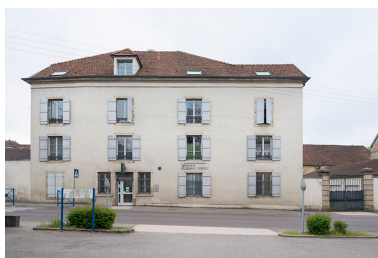
Vue générale du bâtiment. Phot. Jérôme Mongreville IVR43_20177000719NUC4A
