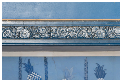
Décor en stuc sur le garde-corps du balcon. Phot. Pierre-Marie Barbe-Richaud IVR26_20257100513NUC4A
