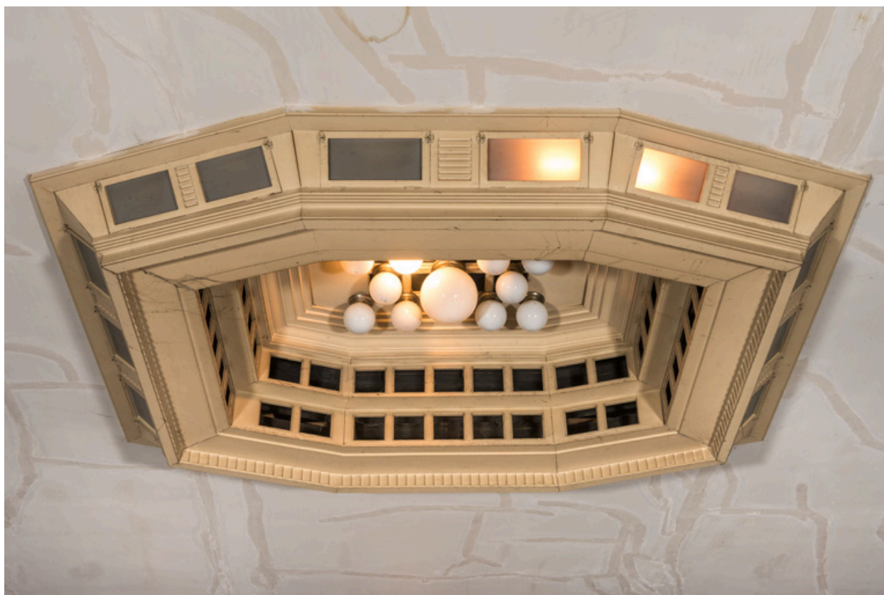
Caisson central lumineux, vu de la scène.
