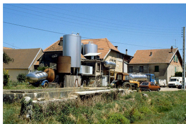
Vue d'ensemble depuis l'ouest. Phot. Laurent Poupard IVR43_19883900231ZA
