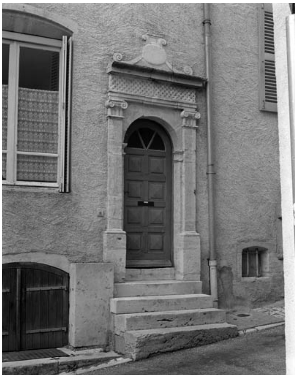
Détail de la porte d'entrée.
