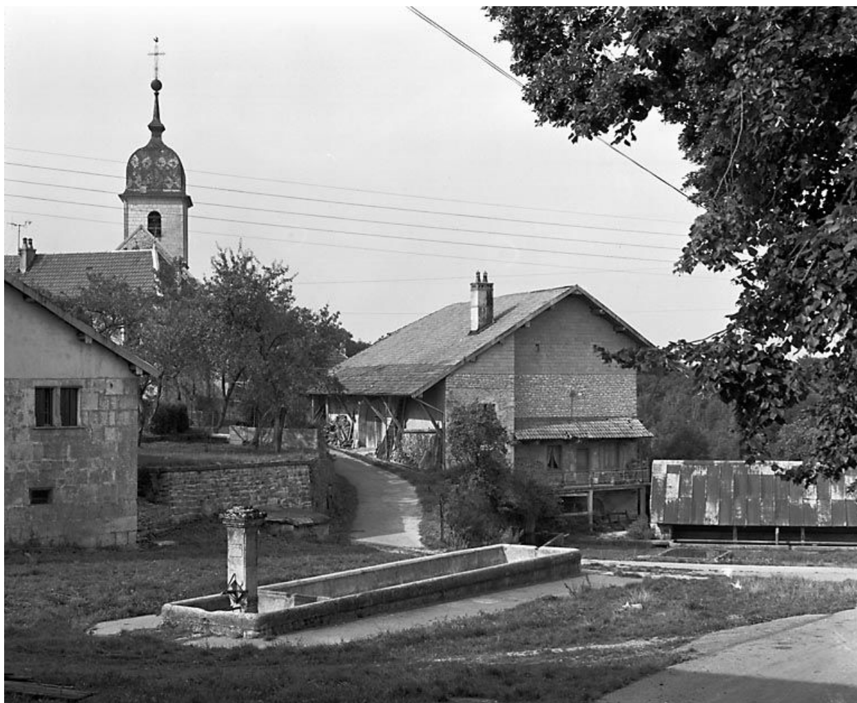
Ferme située place de l'Eglise.
