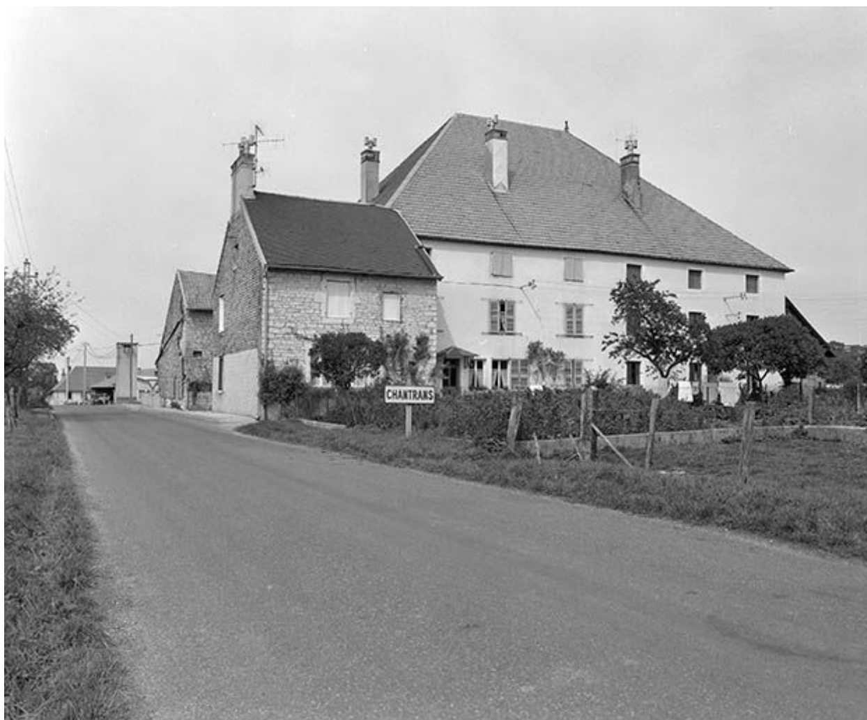
Ferme située 3 route de Pontarlier.
