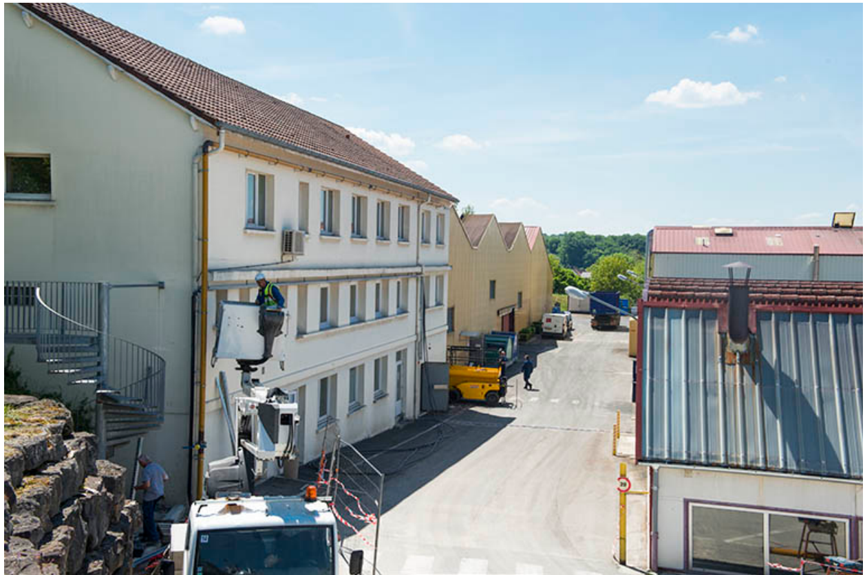
Bâtiment administratif et atelier de fabrication.
