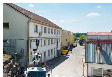
Bâtiment administratif et atelier de fabrication.
