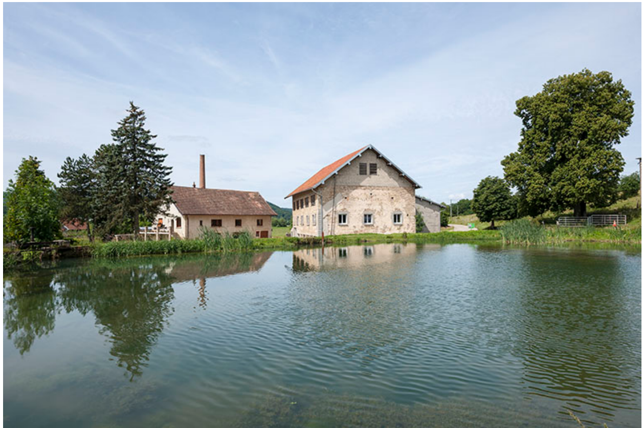
Vue d'ensemble depuis l'étang de retenue.
