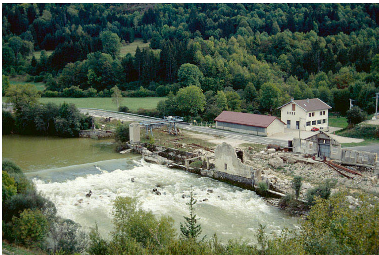
Vue d'ensemble plongeante depuis le nord.
