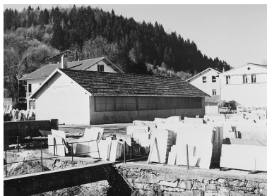
Aire des matières premières et magasin industriel. Phot. Jérôme Mongreville IVR43_19913900024X
