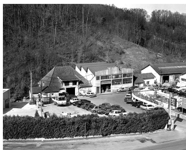
Vue plongeante depuis l'ouest. De gauche à droite : fonderie, garage et atelier de mécanique générale. Phot. Yves Sancey IVR43_19973900622X
