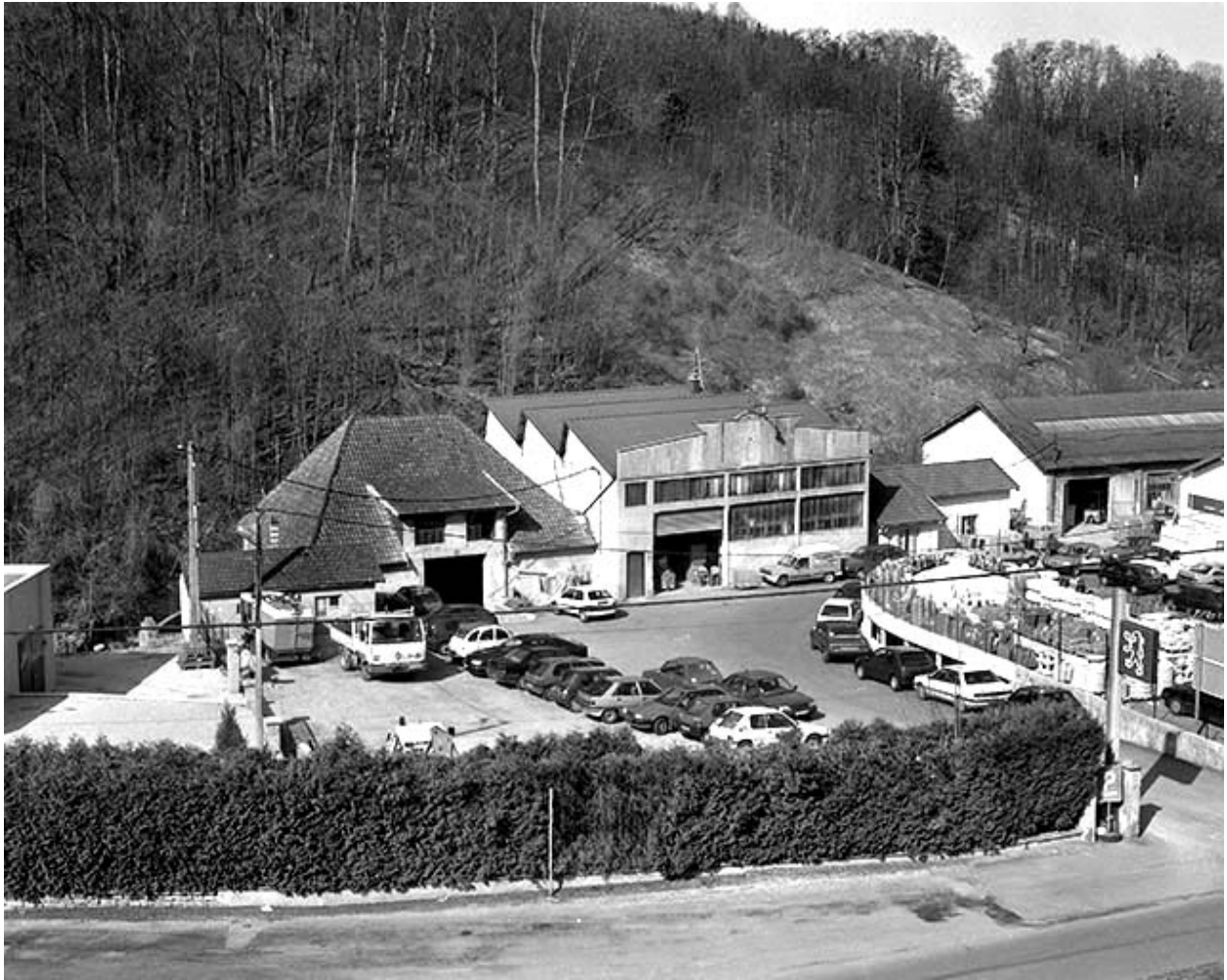
Vue plongeante depuis l'ouest. De gauche à droite : fonderie, garage et atelier de mécanique générale.
