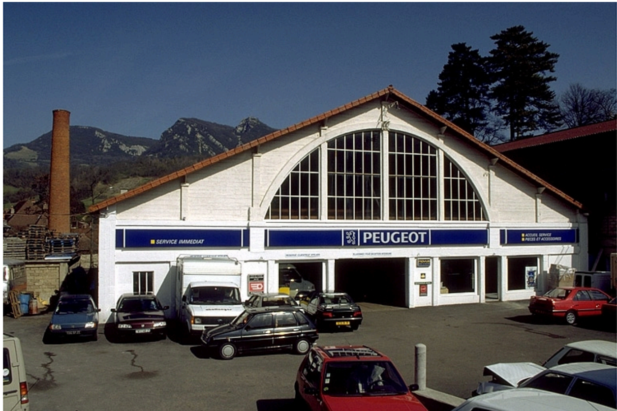
Pignon sud de l'atelier de fabrication.
