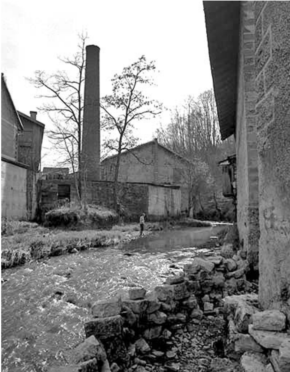
Cheminée et atelier de mécanique générale depuis le nord.
