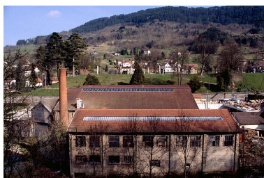
Façade postérieure de l'atelier de mécanique générale. Phot. Yves Sancey IVR43_19973900625ZA
