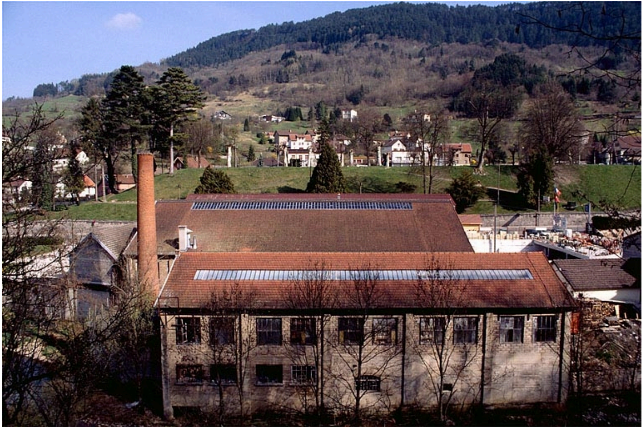
Façade postérieure de l'atelier de mécanique générale.
