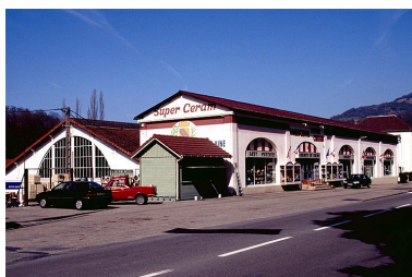
Atelier de fabrication et pièce de séchage. Phot. Yves Sancey IVR43_19973900617ZA
